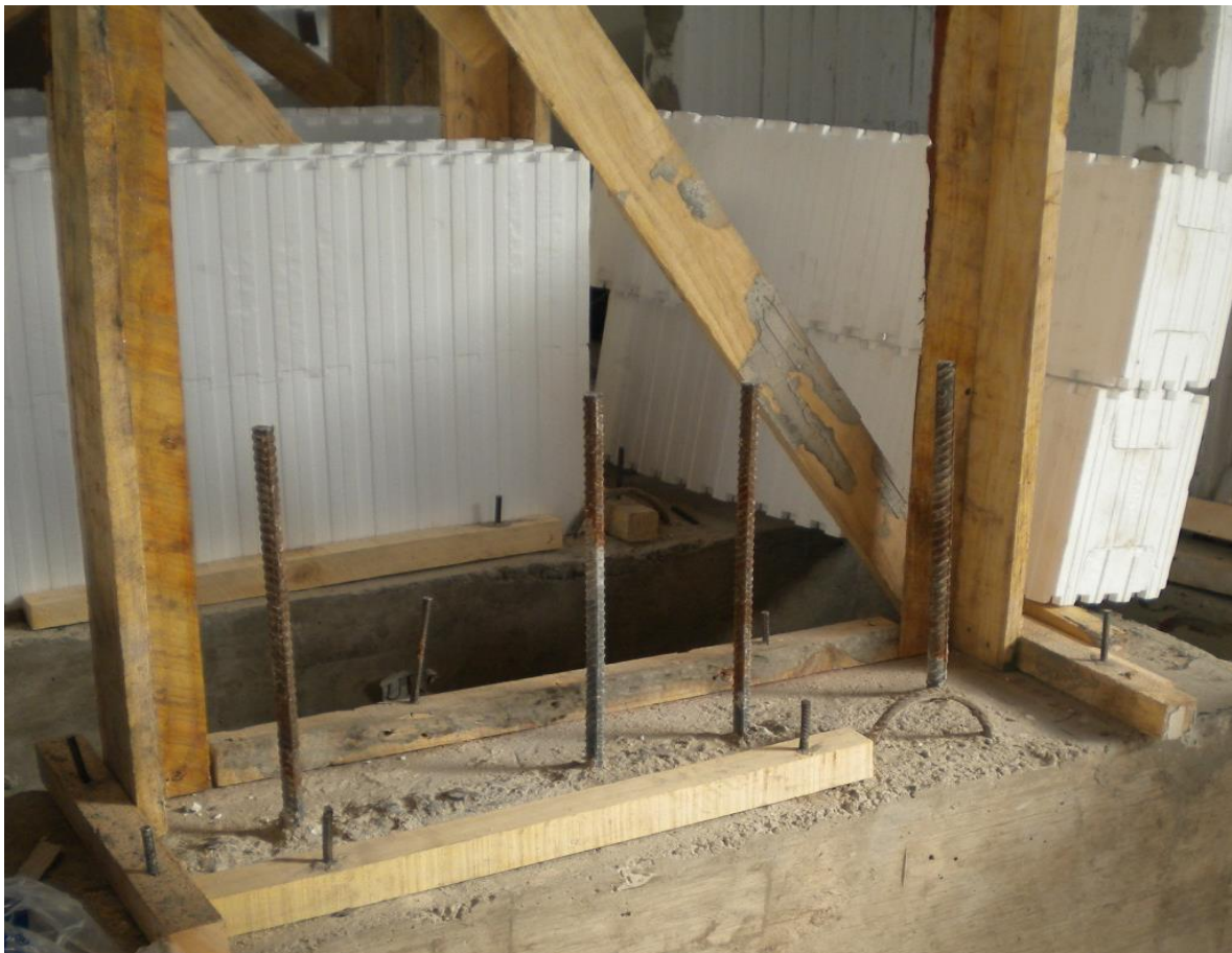
Figura 4.8. Anclajes muros con fibra
