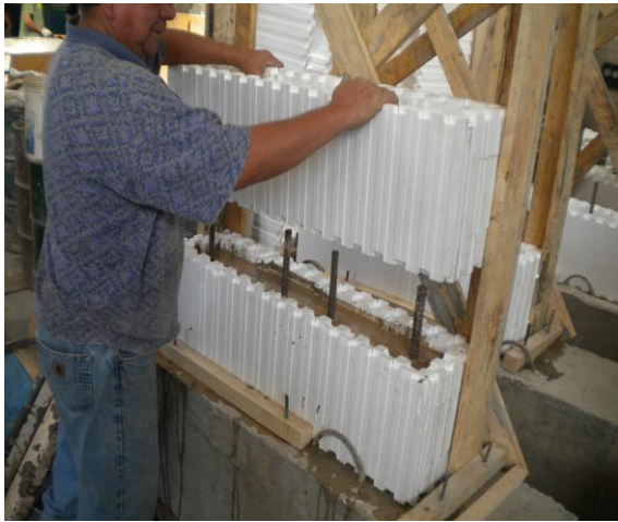
Figura 4.9. Hormigonado por hiladas e instalación de moldajes
