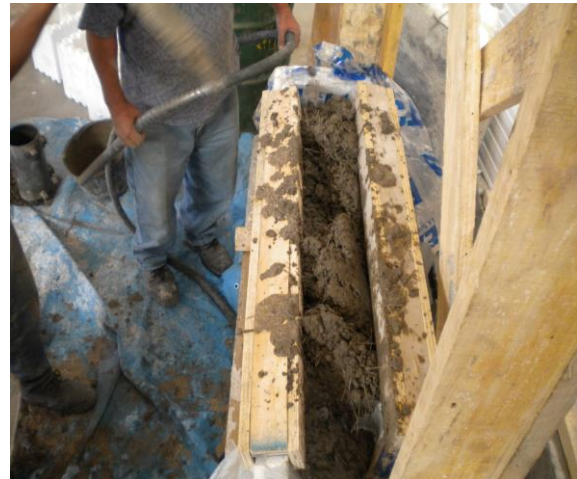
Figura 4.10. Vaciado y vibrado hormigón con fibra.
