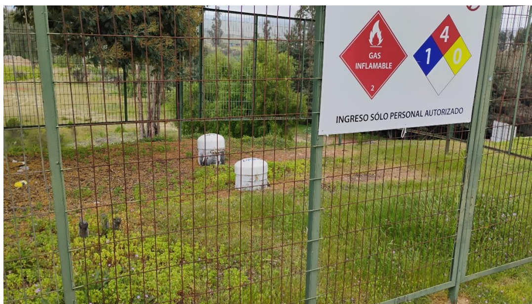
Imagen 3-2: fotografía ubicación punto crítico B.
