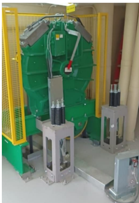
Figura 2.8: Motor de tracción
