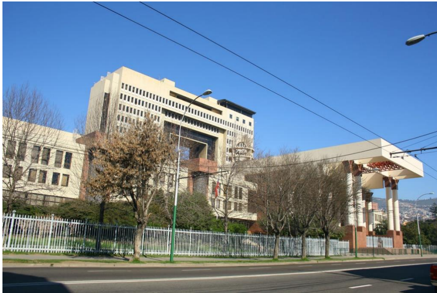
Figura 1: Edificio del Congreso Nacional
