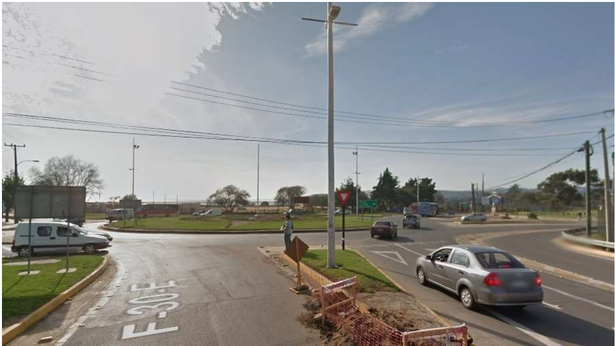
Figura 1-2 Rotonda de Concón vista desde ruta F-30-E Fuente: Maps Street View
