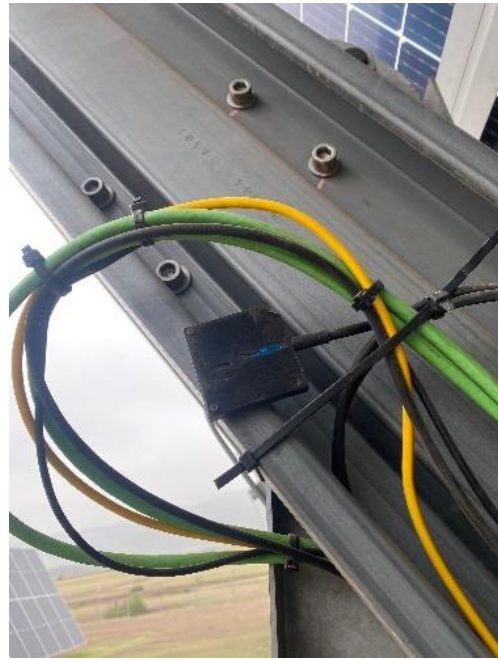
Figura 1.22 y Figura 1.23 Estado de sensores y cables en tracker posterior a mantenimiento mensual
