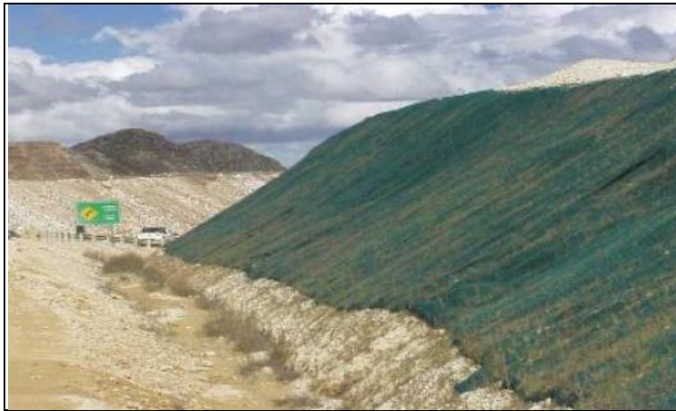
Figura 5-4: Mantas sobre talud
