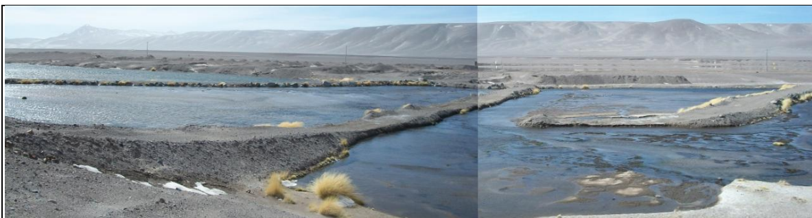
Figura 5-7: Serpentines ubicados en la descarga del río La Ola en tranque La Ola
