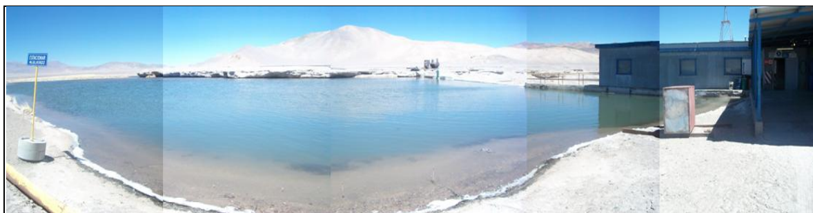
Figura 2-14: Vista panorámica tranque La Ola e instalaciones
