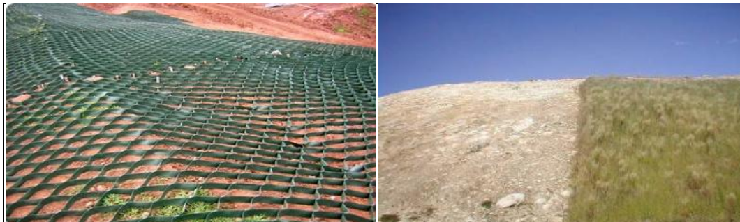
Figura 5-5: Geoceldas sobre talud y reforestación en talud con flora nativa en desierto
