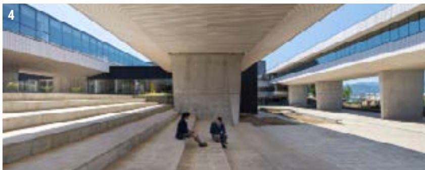
1: Ingreso al Liceo; 2: Circulación Gimnasio; 3: Circulación para la pasarela; 4: Patio bajo las Aulas .
