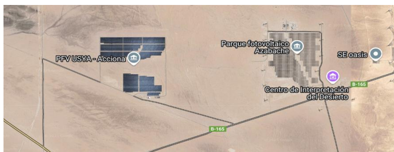
Figura 23: Plantas USYA y AZABACHE ubicadas en Calama. Imagen extraída desde explorador solar del Ministerio de Energía. https://solar.minenergia.cl/exploracion .
