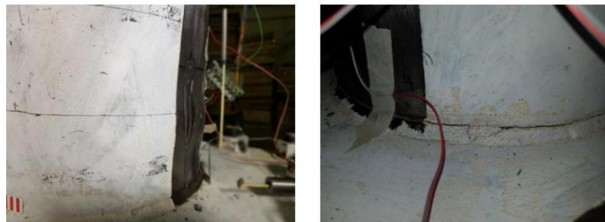
Figura 6. Registro fotográfico Ensayo 2 Experimental Julio 2019, DOOCC
