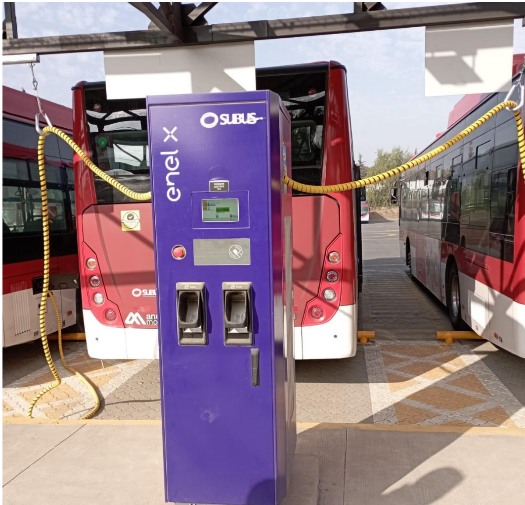
Figura 13: Cargador Enel X, se muestran ambas mangueras de carga. [foto propia].
