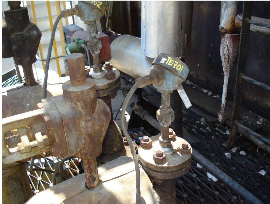
Figura 19: Termocupla inserta en vaina Fuente: Elaboración propia
