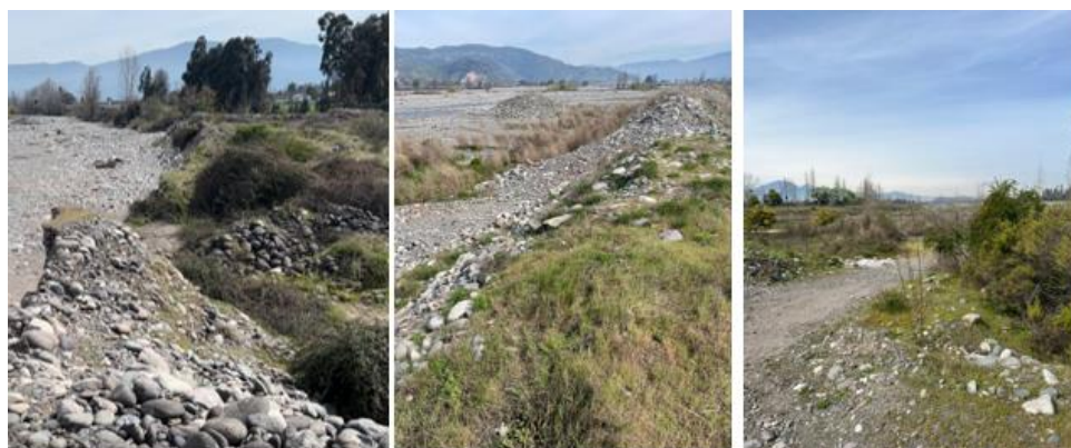
Figura 3. Daños de ribera norte del río Tinguiririca. Fuente: Elaboración propia.
