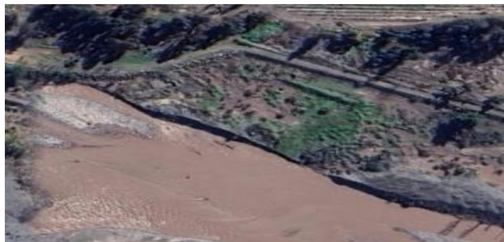
Figura 26. Primera zona crítica.
