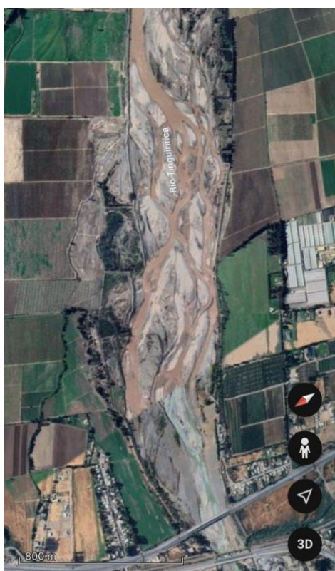
Figura 11. Río Tinguiririca sector puente Ruta 5.
