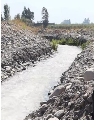
Figura 20. Bocatoma canal La Palma.
