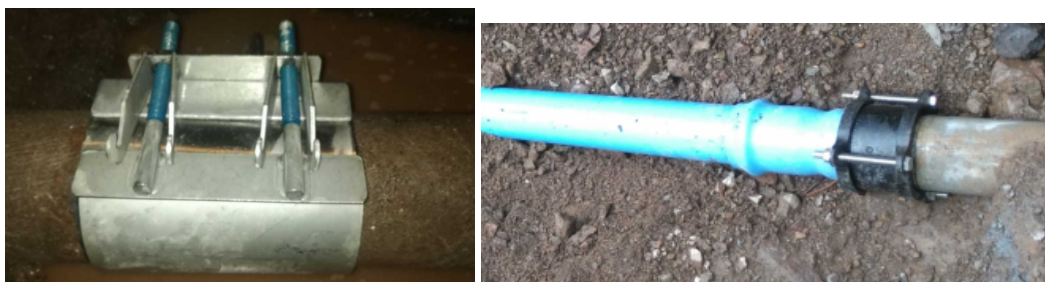
Figura 16: Izq: Tubería reparada con abrazadera producto de una rotura de menor gravedad. Der: Reposición de un tramo de tubería de Asbesto Cemento por una tubería de PVC, producto de una rotura de mayor gravedad. Fuente: Informes Orden de Trabajo Aguas de Antofagasta S.A.
