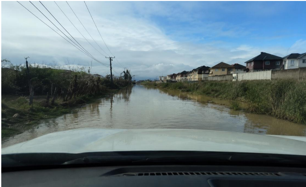
Ilustración 1: Condición de anegamiento de la vía en estudio
