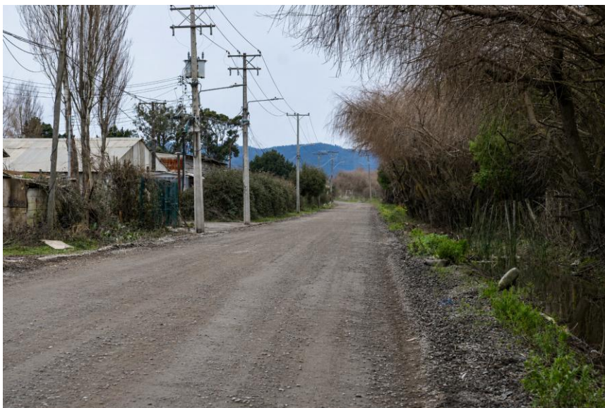
Ilustración 14: Estado actual del camino
