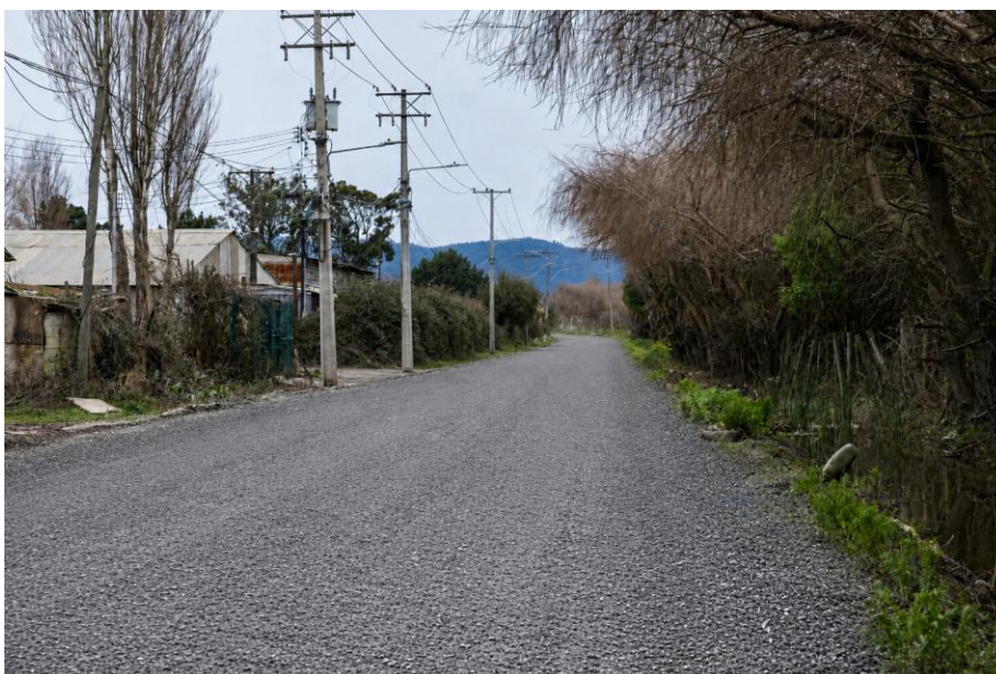
Ilustración 15: Camino luego de la aplicación del TSD
