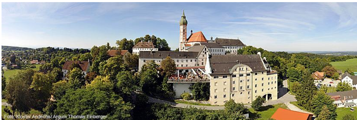
Ilustración 29 Vista externa del monasterio de Andechs
