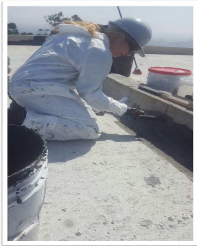
Imagen N°1- 2: Aplicación MasterSeal 550 en Obra.
