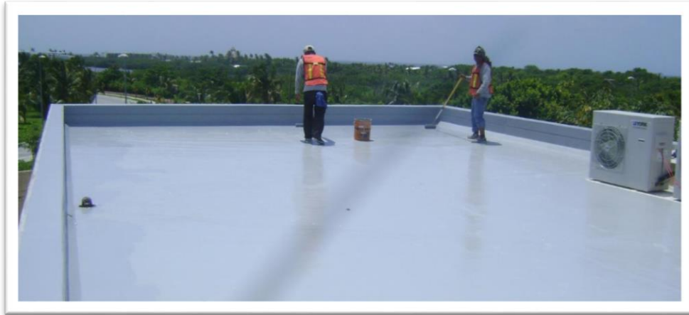
Imagen N°1- 3: Aplicación MasterSeal Traffic 1500
