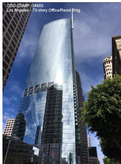
Figura 12: Edificio CA010 “Los Angeles – 73 pisos – edificio residencial/oficinas”.
