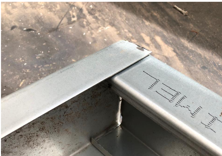
Figura 51: Unión utilizada entre perfil c y u.
