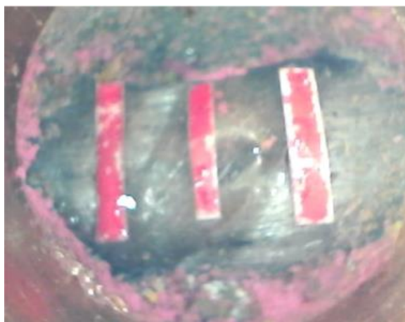
Figura 20 Barra FRP limpia y con targets instalados
