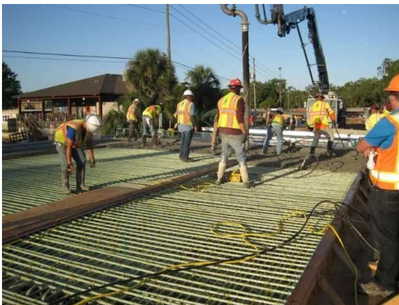
Figura 1 Vaciado de concreto en el tablero del puente reforzado con FRP (Fuente: Nanni, 2018)
