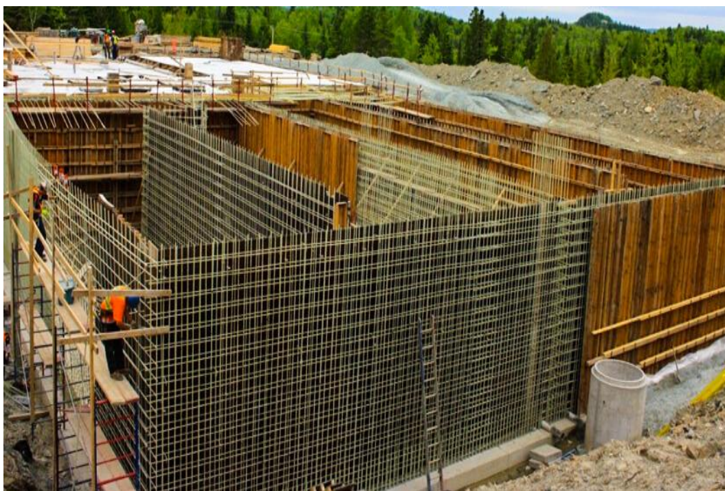
Figura 5 Proceso de construcción del estanque de agua en Thetford Mines (Galvez, 2022).
