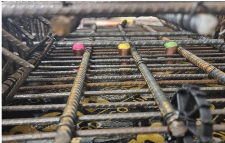
Figura 16 Tubos de cobre instalados rellenos de masa epóxica
