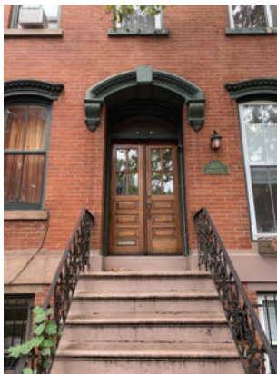
Entrada, Peldaños Frontales y Baranda Desde 1st Street.
