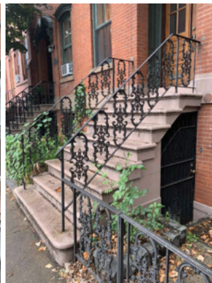
Peldaños Frontales y Baranda Desde 1st Street.
