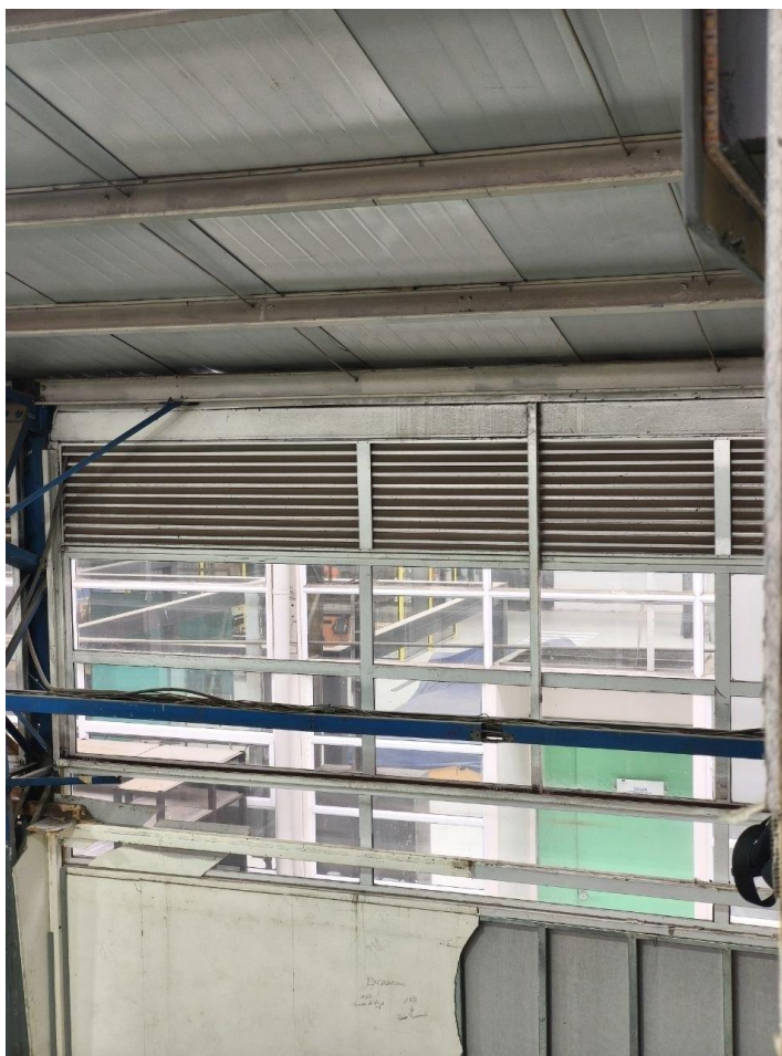
Figura 1-6. Pared pasillo: ventana superior y franja continua de celosías. Fuente: registro propio.
