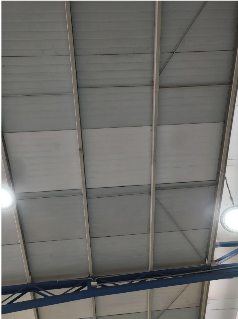
Figura 1-9. Cara interior visible de la techumbre Instapanel y estructura secundaria de apoyo. Fuente: registro propio.
