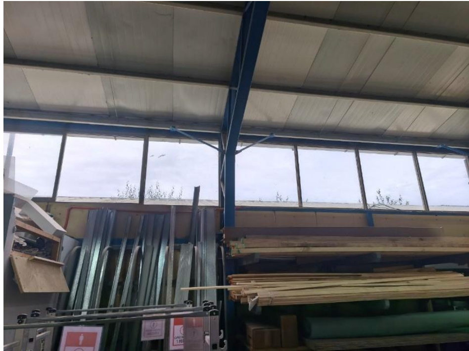
Figura 1-3. Ventanas superiores de vidrio simple con marco de aluminio en el taller. Fuente: registro propio.
