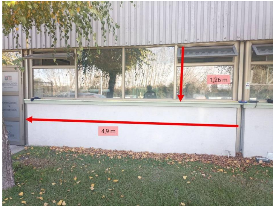
Figura 1-5. Levantamiento dimensional de la pared cancha: tramo inferior y altura de ventana registrada en terreno. Fuente: registro propio.
