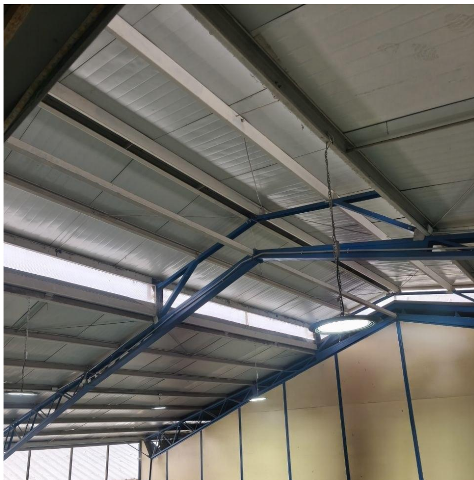
Figura 1-8. Franja translúcida existente en la techumbre del taller. Fuente: registro propio.
