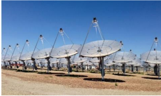
Figura 9: Planta de concentración solar (PDC) en Utah, Estados Unidos.
