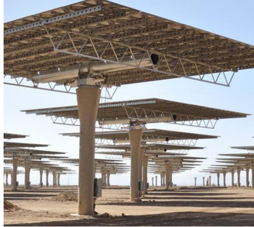
Figura 33: Cimientos de hormigón para heliostatos.
