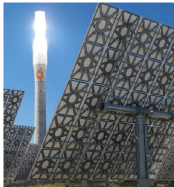
Figura 28: Vigas de acero unidas para estructura de heliostato.
