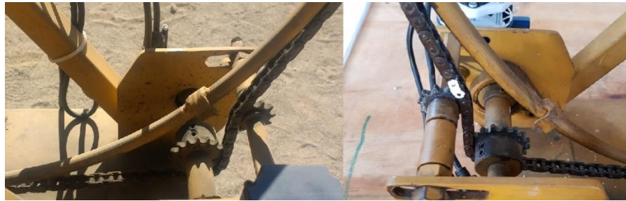
Figura 97: Antes y después de mantenimiento a sistema de transmisión del heliostato.
