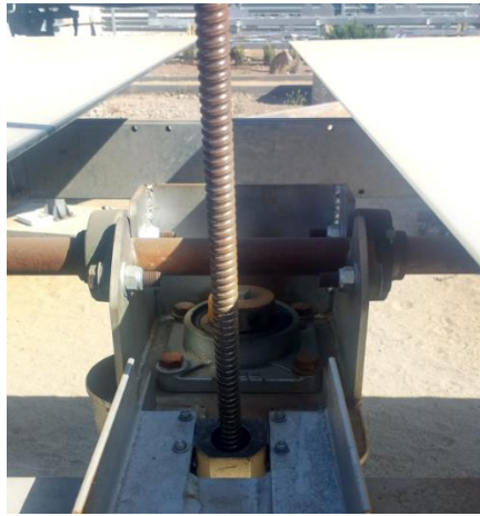
Figura 72: Husillo y eje central de heliostato descrito.
