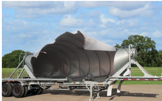
Figura 21: Falla por sobrepresión sobre estructura cilíndrica del silo (BTI, 2018)
