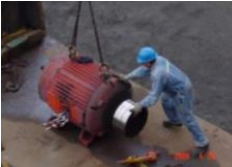
Fuente: Archivo Fundición Ilo Figura 1-6. Motor gancho principal
