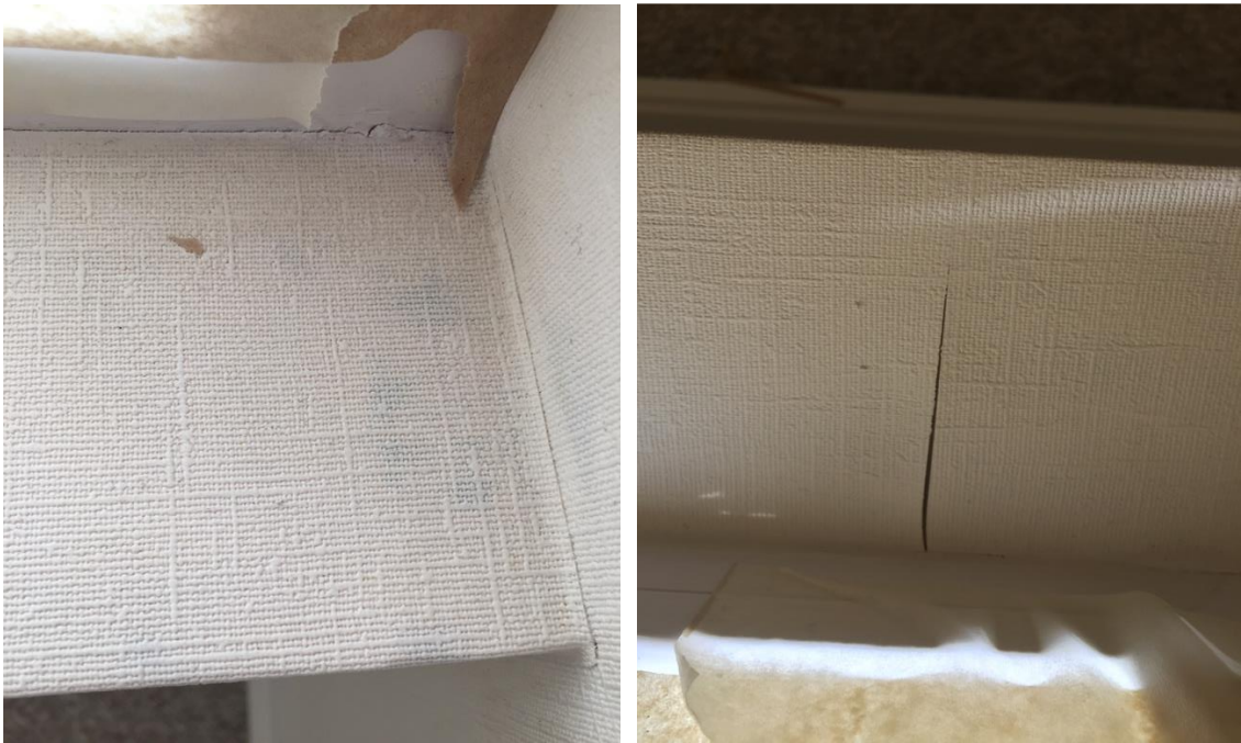
Fuente Proyecto Edificio Viña Norte.
