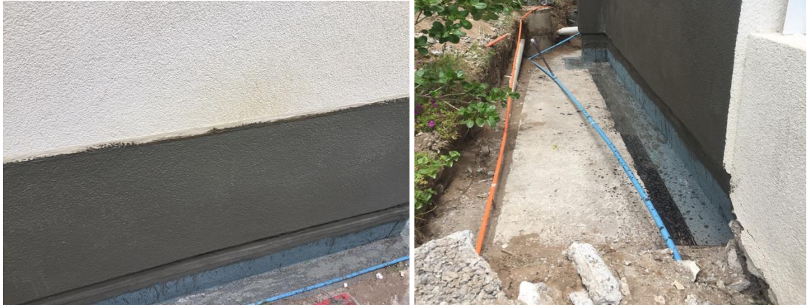
Fuente Proyecto Edificio Bellavista.
