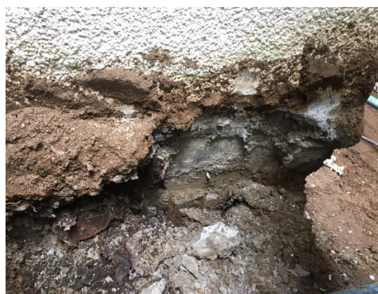
Figura 2-4. Losa de estacionamiento subterráneo inyectada con poliuretano.
