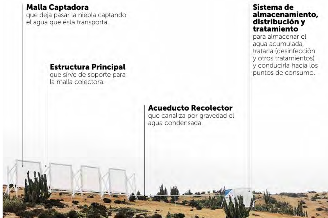
Fig. 6. Componentes de un sistema atrapaniebla. Fuente: Fundación Un Alto en el Desierto y Ministerio de Salud (2020), ATRAPANIEBLA.(s.f.)
