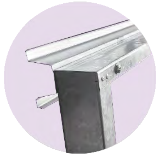
Fig. 77 Detalle de fijaciones con remaches y pernos Fuente: Elaboración propia (2026)
