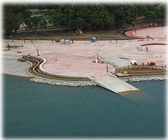
Figura 1-5: Rampa para embarcaciones menores
