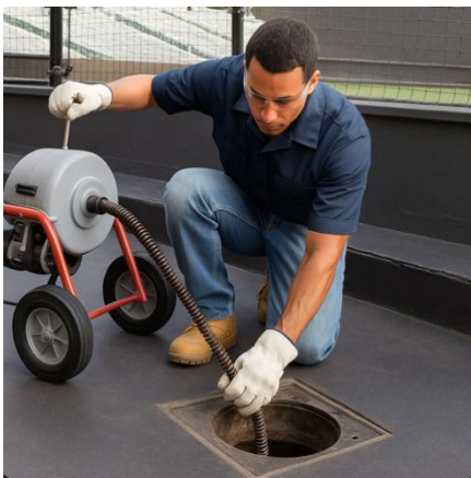
Figura 4-10. Ejemplo de limpieza de cámara de inspección mediante cable espiral desobstructor. Fuente: Elaboración propia (IA).
