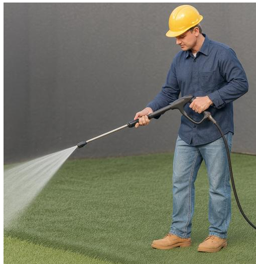
Figura 4-9. Ejemplo de hidro lavado a baja presión. Fuente: Elaboración propia (IA).
