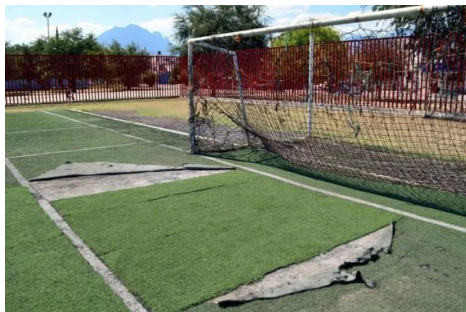
Figura 4-3. Desprendimiento de uniones en césped sintético. Fuente: Diario “El Norte”.
