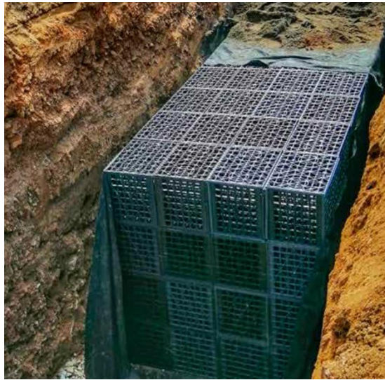
Figura 3-4. Zanja drenante con cubos dren. Fuente: Catalogoarquitectura.cl
