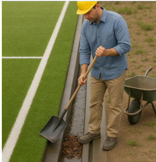
Figura 4-6. Limpieza de canaletas del sistema de drenaje. Fuente: Elaboración propia (IA).
