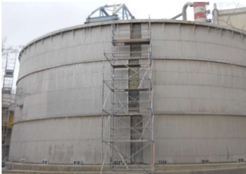
Figura 3. Vista de eje 180^\circ del tanque Clarificador N°2
