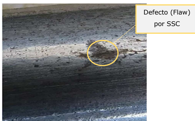
Figura 11. Defecto (flaw) similar a agrietamiento.
