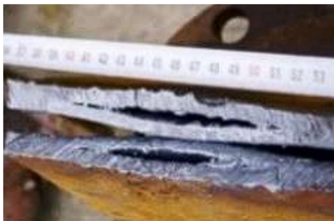
Figura A1. 11. Laminaciones Fuente: Evaluación parte 13 API 579-1/ASME FFS-1
