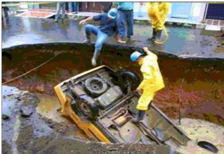
Fotografía N°1: Efectos de rotura de alcantarillado
