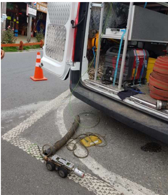
Fotografía N°3.: Camión adaptado para realizar teleinspección
