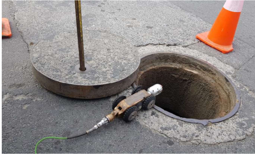
Fotografía N°4: Cámara Robótica antes de ingreso a colector
