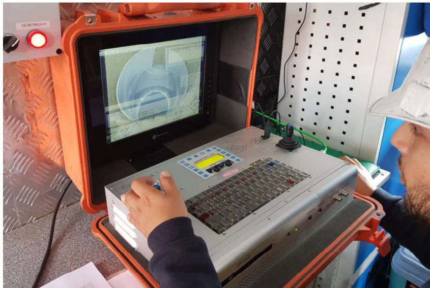
Fotografía N°5: Teleinspección a Colector, por operario Certificado
