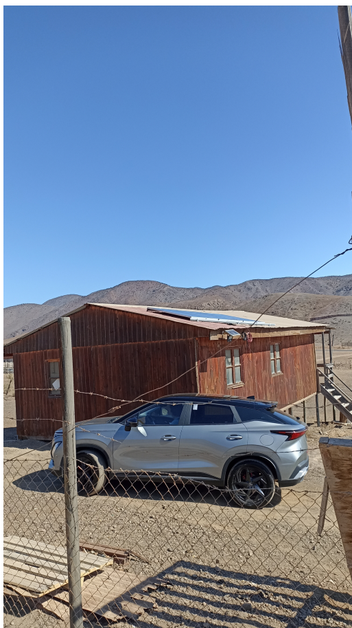
Figura 3.18: Paneles montados sobre el techo de la cabaña
