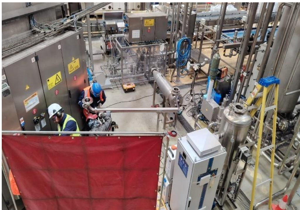
Ilustración 10 Trabajos de instalación
