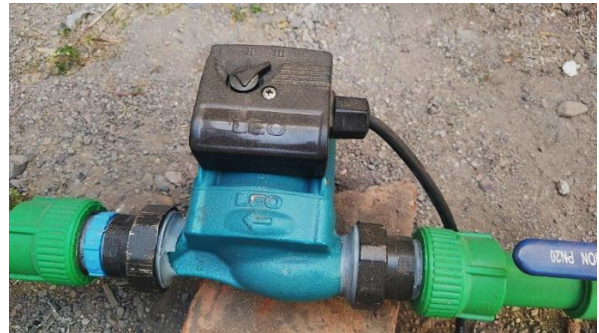
Figura 4- 17. Bomba Circuladora de la succión del agua salada.
