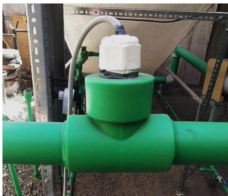
Figura 4- 21. Sensor PT100 ajustado en el interior de la tubería por medio de una prensa estopa.
