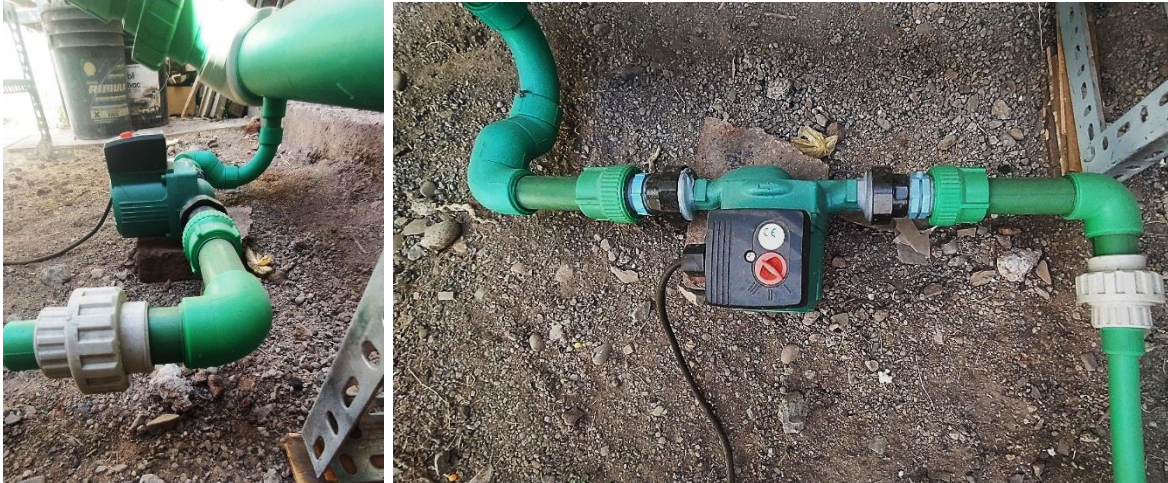
Figura 4- 18. Sifón y bomba del retorno de la salmuera.
