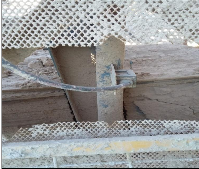
Figura 2-13. Rejilla metálica lateral del contrapeso CV-113.
