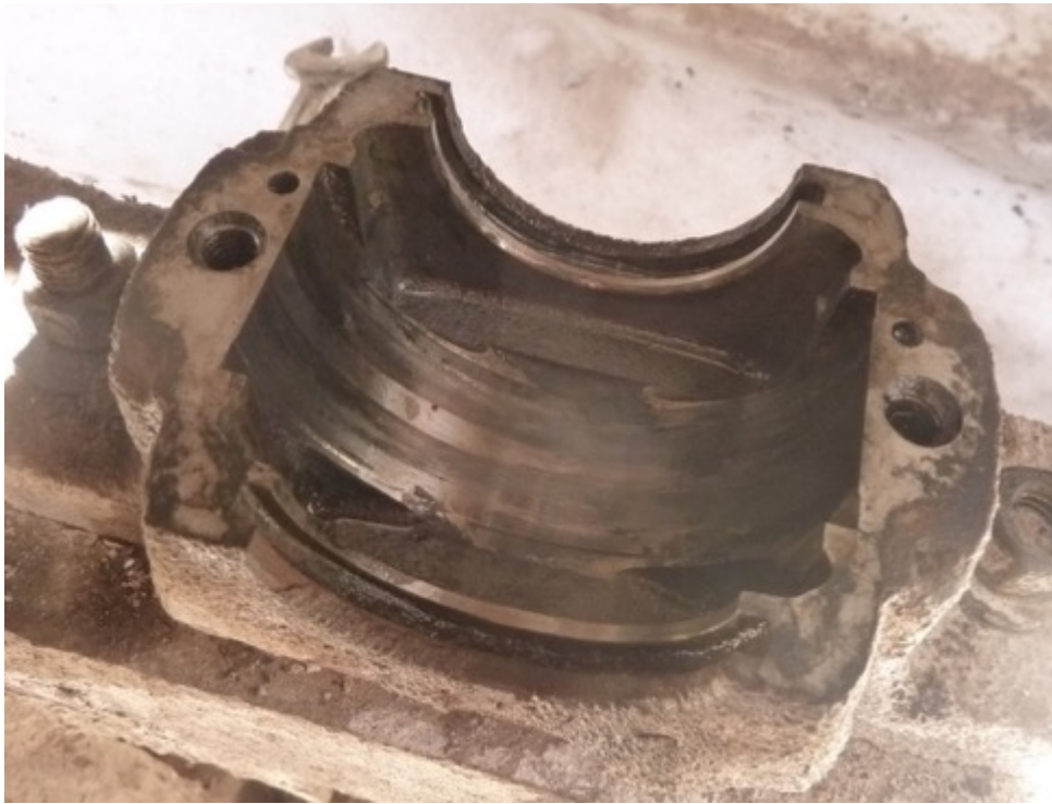
Figura 2.68 Inspección del estado del alojamiento de la base del soporte.
