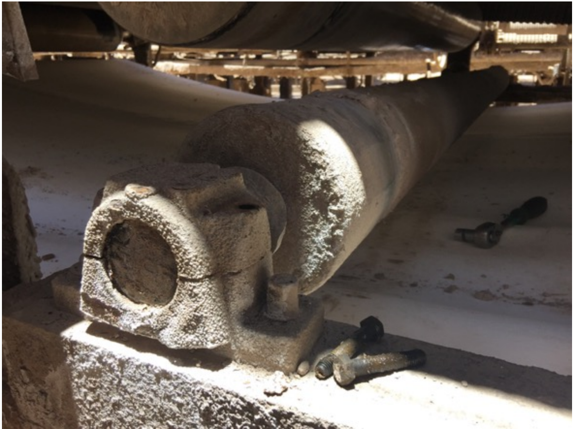
Figura 2.11 Contaminación sólida completamente adherida al soporte.
