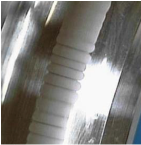
Figura 1.57 Marca típica ondulada causada por una fuga de corriente.
