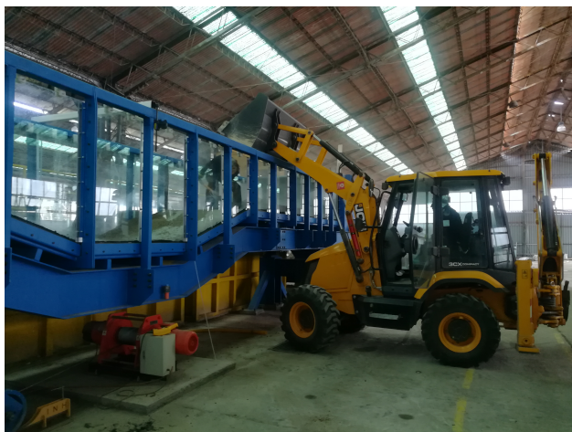
Figura 4.4 Transporte de sedimentos al canal de socavación local en pilas con retroexcavadora.
