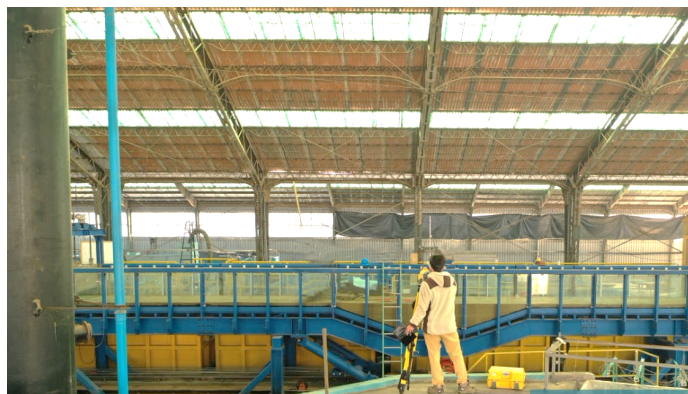
Figura 4.6 Trabajo de definición de cotas de nivel para extensión de sedimento en canal de socavación en pilas.
