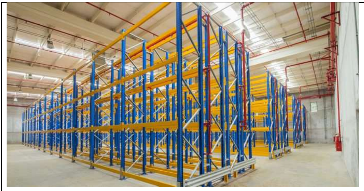
Figura 3-2: Configuración interior bodega almacenamiento aerosoles
