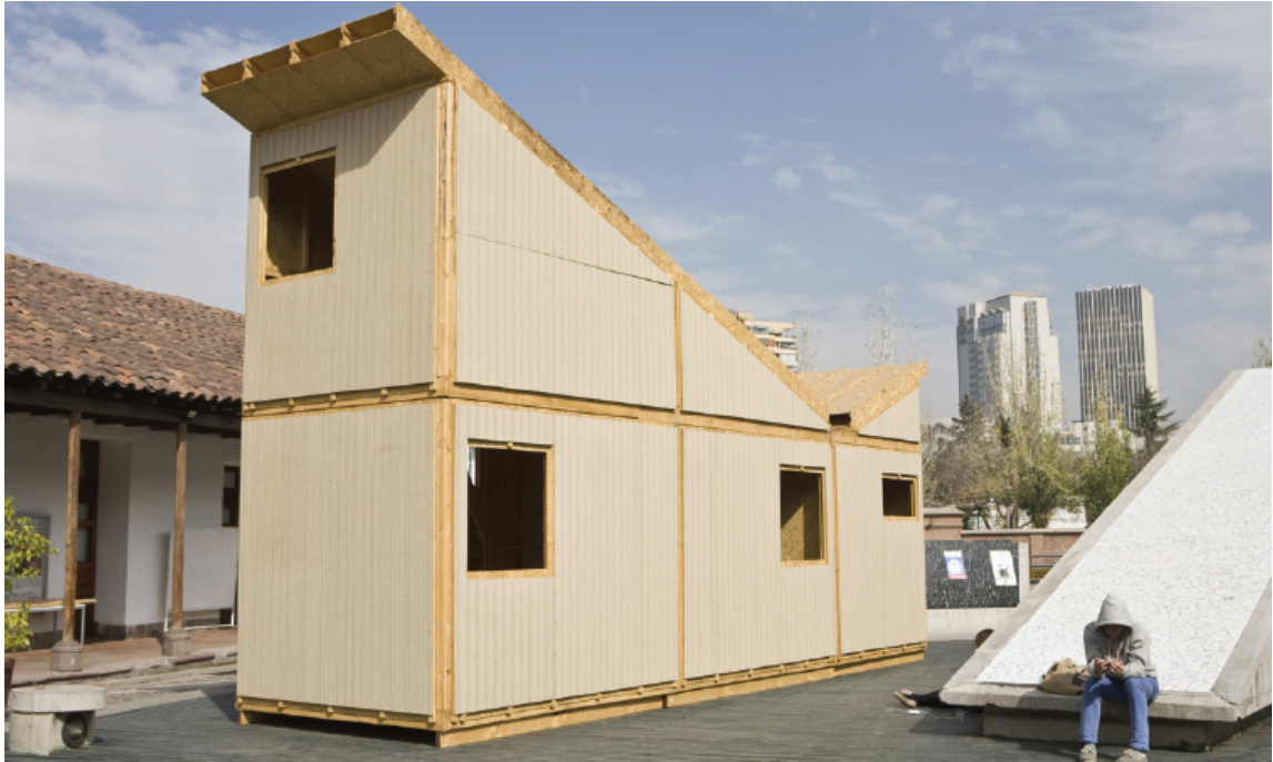
Figura 4.7: Prototipo de vivienda de emergencia del proyecto VED Fuente: ( Ministerio de Obras Publicas, 2014 )
