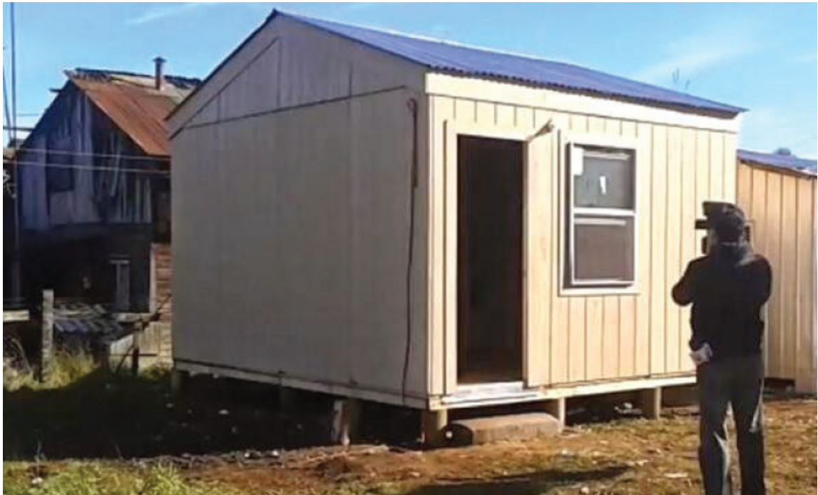
Figura 4.10: Vivienda de emergencia entregada en la Región de los Lagos
