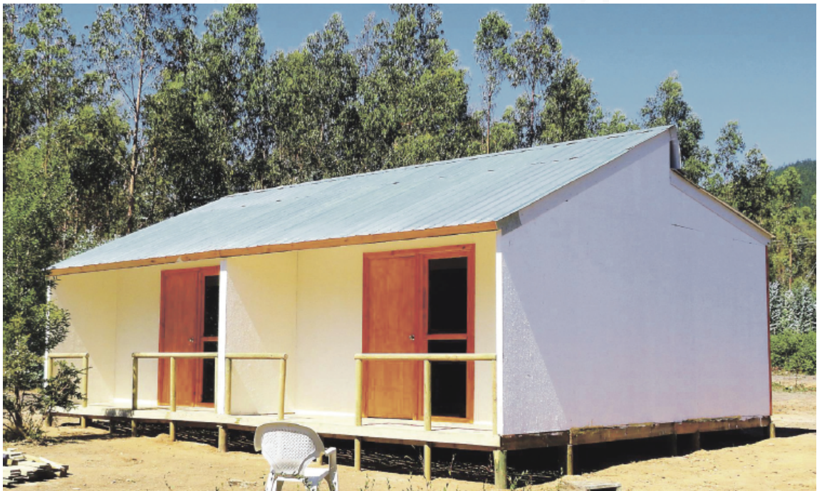
Figura 4.6: Vivienda de emergencia utilizada en el proyecto FONDEF D09I1058 Fuente: ( Ministerio de Obras Publicas, 2014 )
