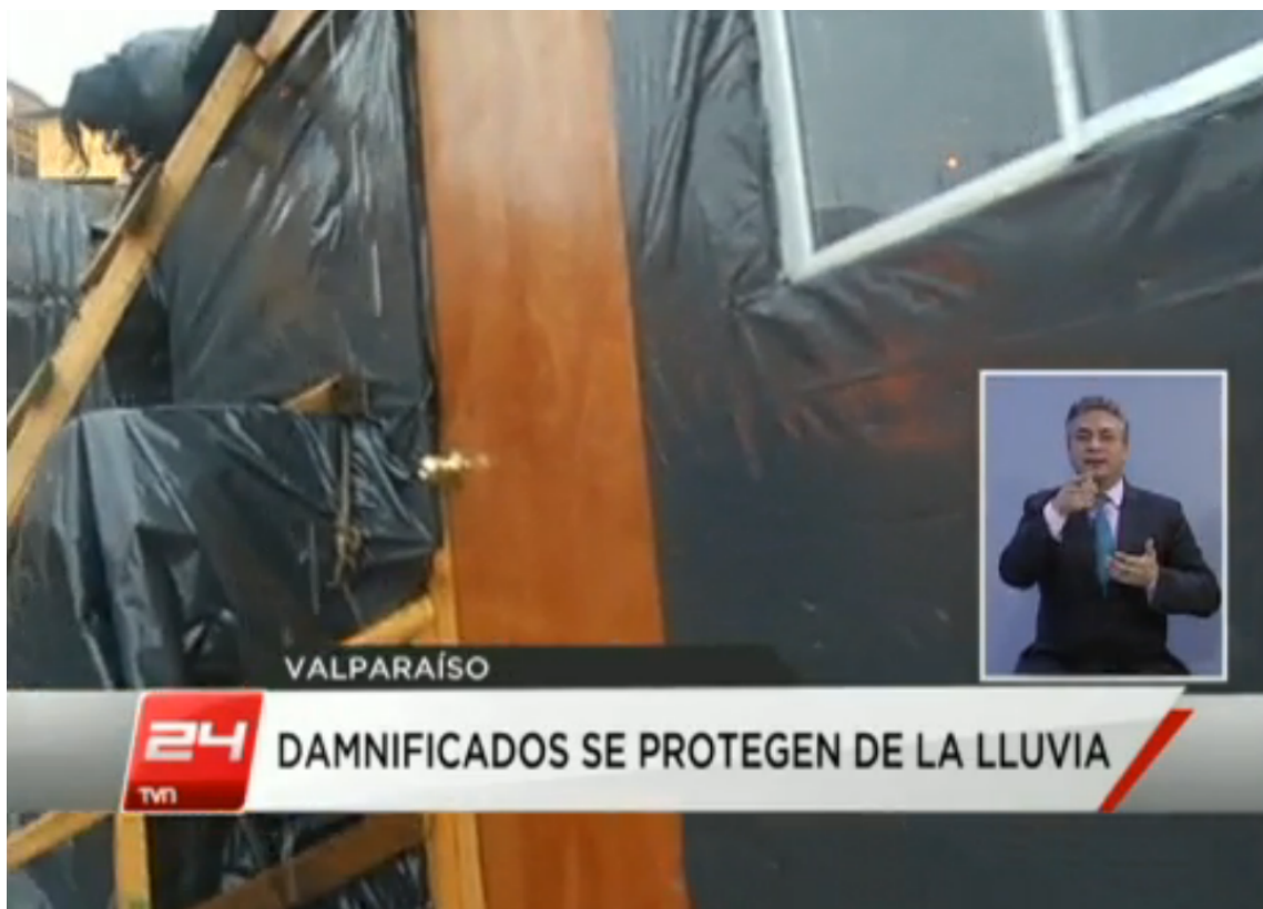
Figura 9.5: Viviendas de emergencia forradas con nylon
