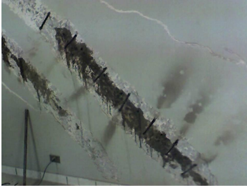
Figura 2-6. Reparación de fisuras con corchetes
