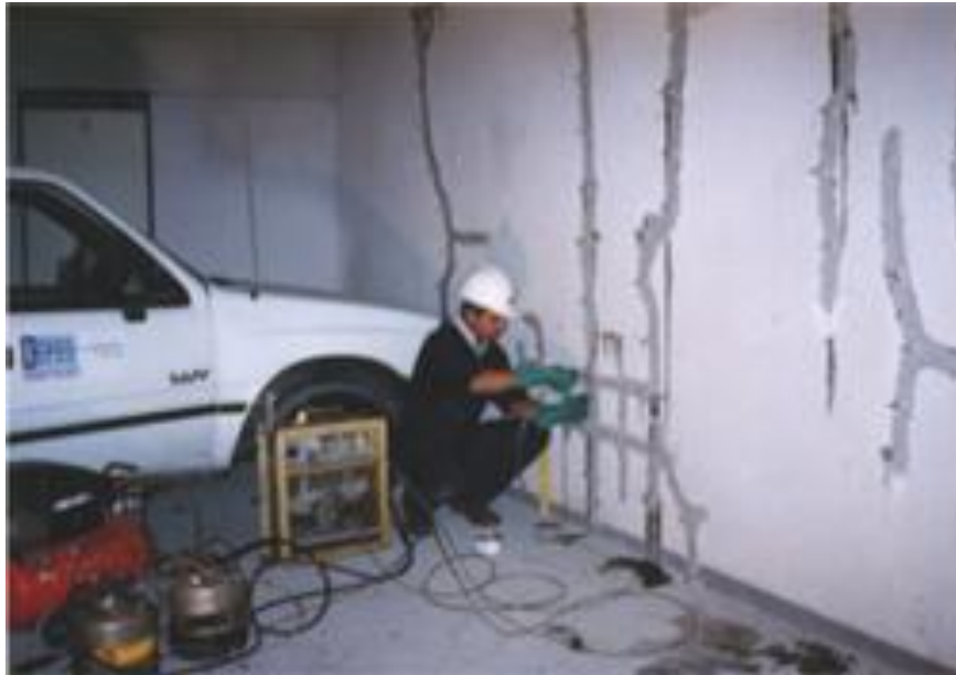
Figura 2-4. Inyectado de resina epóxica
