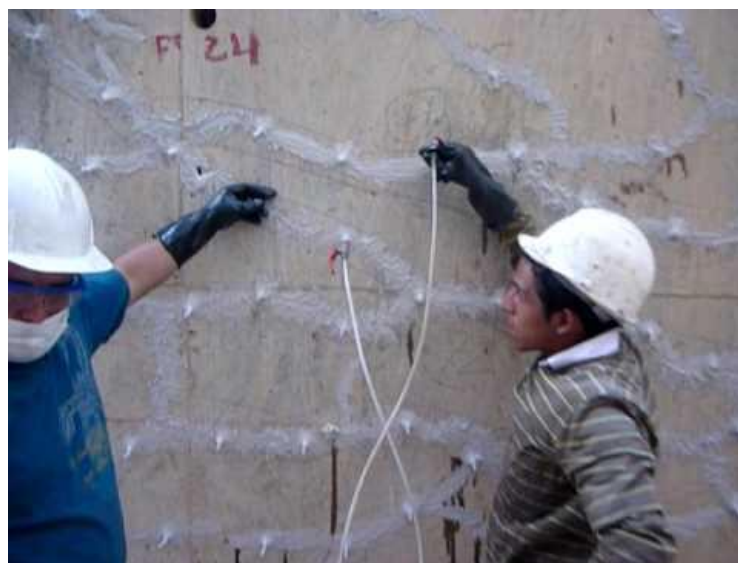
Figura 2-2.Sellado para colocación de resina
