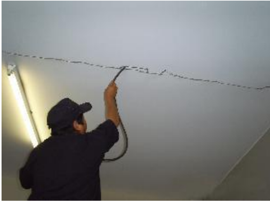
Figura 2-1.Limpieza de fisuras
