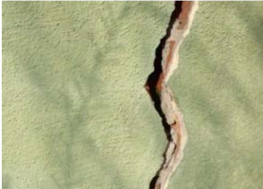
Figura 2-5. Apertura de fisura para sello
