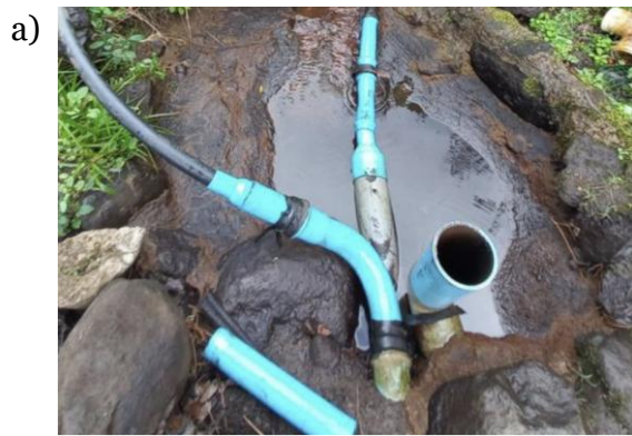
Figura 3-3. Captación Cortafuegos situada directamente en el cauce del estero. a) Piscina de captación vista aguas arriba. b) Piscina de captación en evento de precipitaciones. Fuente: Municipalidad Juan Fernández (2025).
