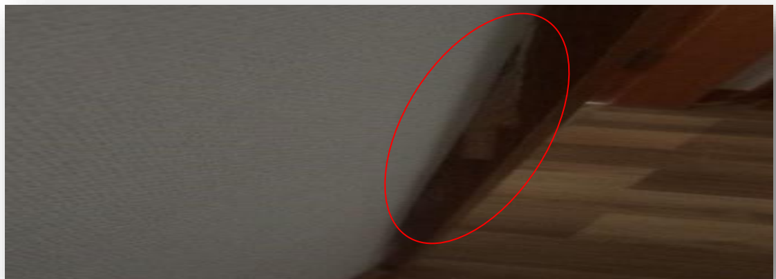
Fuente: Registro Viconsal Limitada. Figura 2-22 Enchapes roto en centro de puertas
