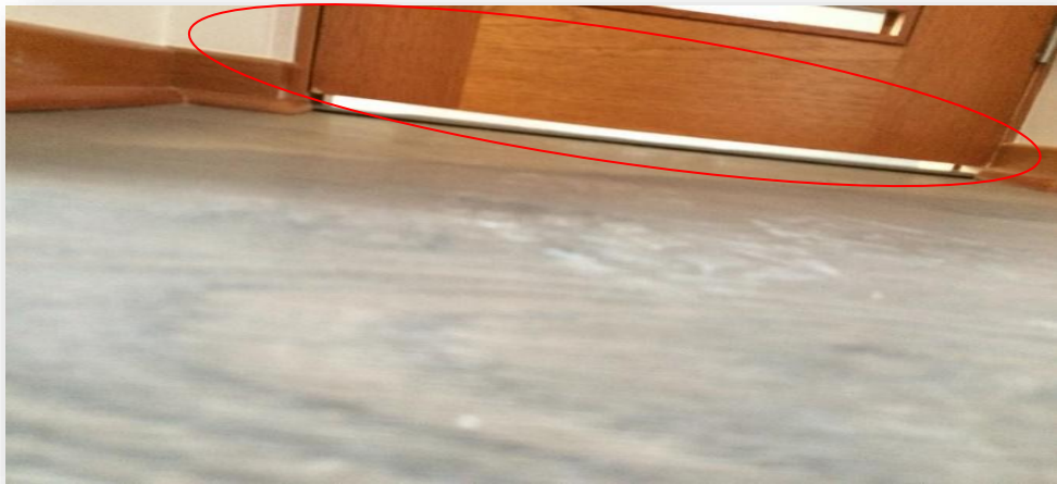
Fuente: Registro Viconsá Limitada. Figura 2-24 Puertas cortas.
