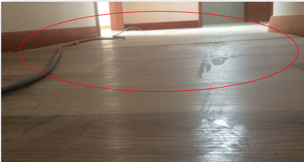
Fuente: Registro Viconsá Limitada. Figura 2-13 Abertura entre uniones piso flotante
