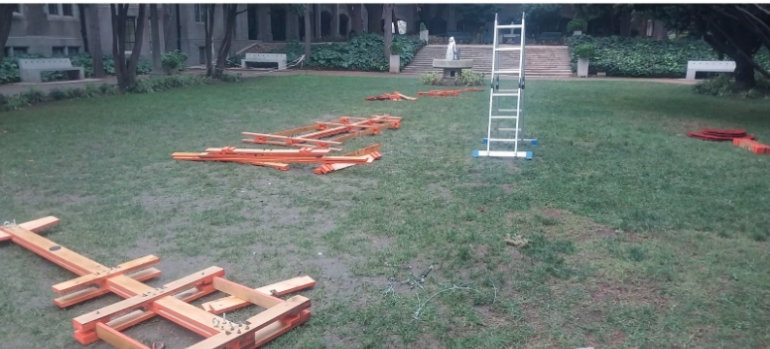
Desmontaje en patio del cañón.
