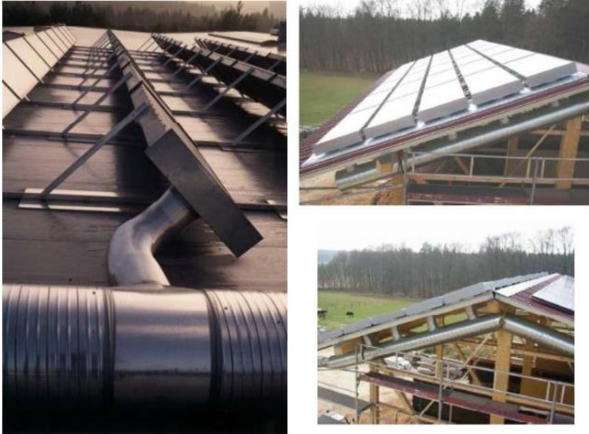
Ilustración 8: Sistema solar térmico, aire.
