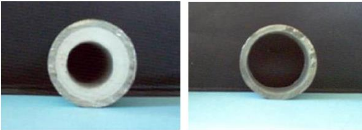
Ilustración 52: Limpieza química tubería
