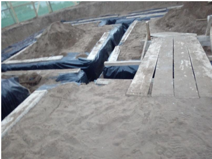
Figura 4-9. Impermeabilización de fundaciones.
