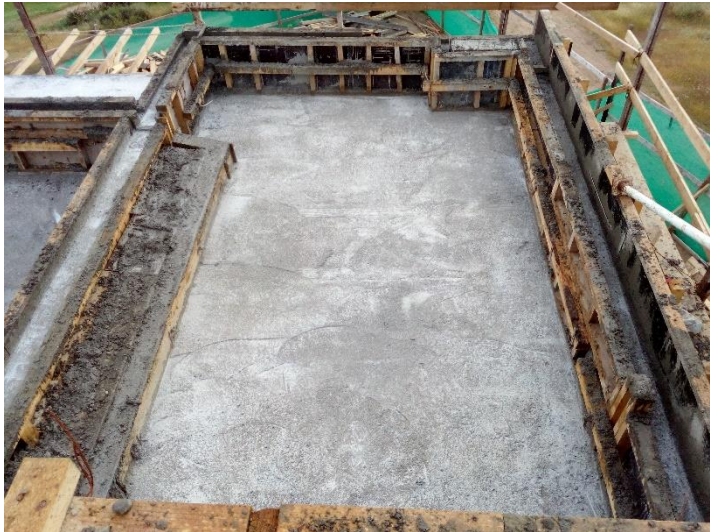
Figura 4-32. Losa y vigas hormigonadas.
