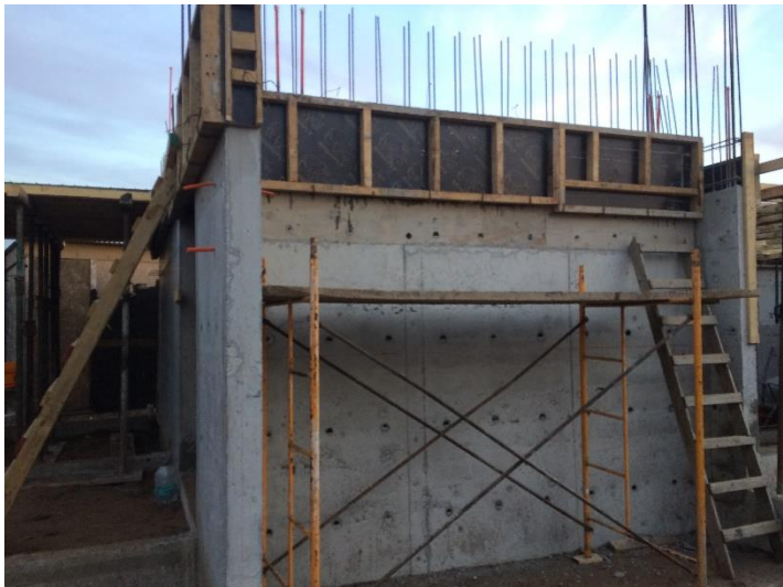
Figura 4-21. Colocación de rebalse de losa.
