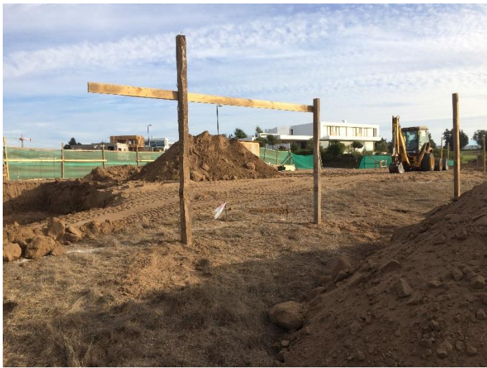
Figura 4-6. Construcción de cerco perimetral
