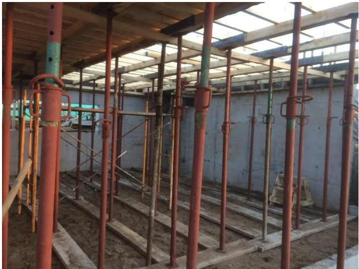
Figura 4-23. Moldaje de losa.
