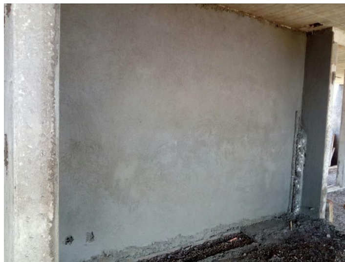
Figura 4-36. Estuco de muro interior.
