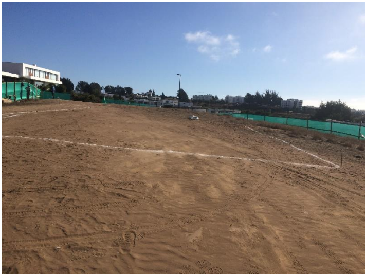
Figura 4-3. Trazado previo.
