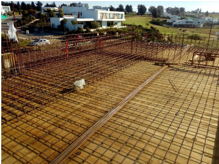
Figura 4-29. Enfierradura de losa.
