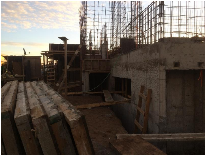
Figura 4-20. Descimbre de muro.
