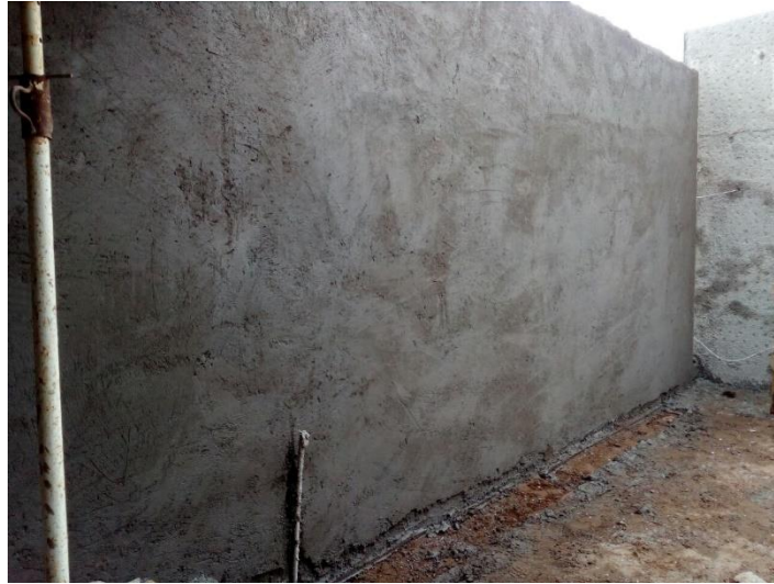
Figura 4-37. Estuco de muros exterior.
