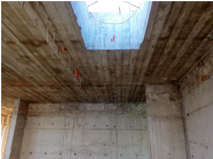
Figura 4-33. Losa a la vista.
