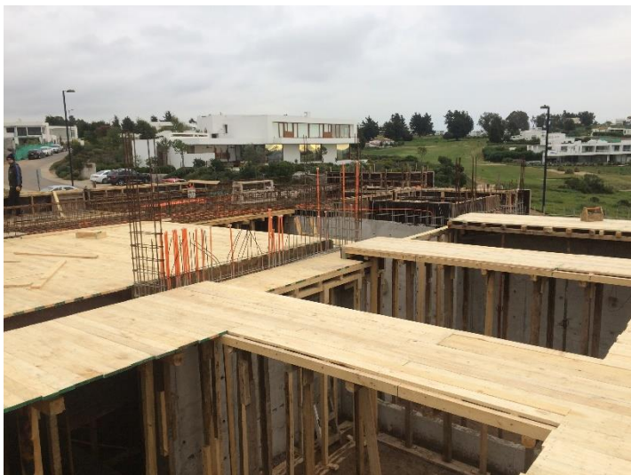
Figura 4-27. Entablado para vigas y losa a la vista.
