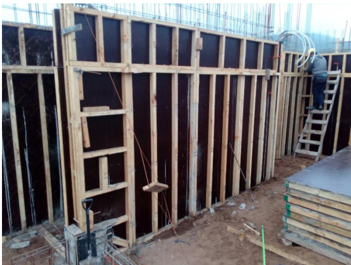
Figura 4-16. Moldaje para muro.
