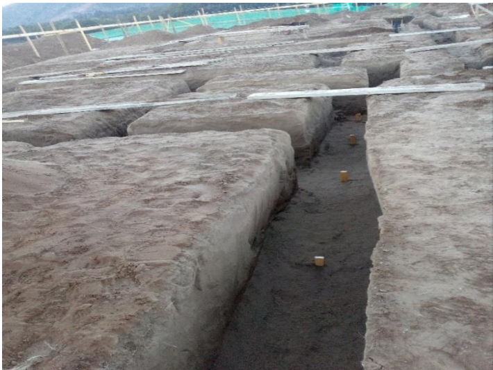
Figura 4-11. Estacas para dar altura al sello de fundación.
