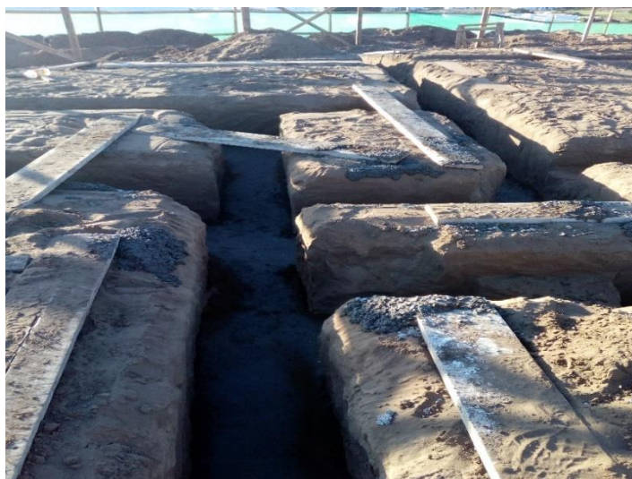
Figura 4-12. Hormigonado del sello de fundación.
