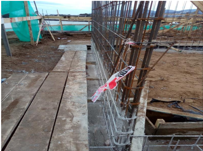
Figura 4-14. Hormigonado de fundaciones.
