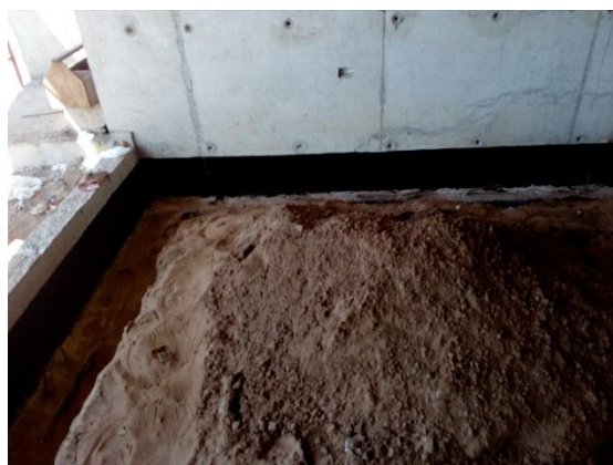
Figura 3-3. Impermeabilización con CAVE-SEAL.
