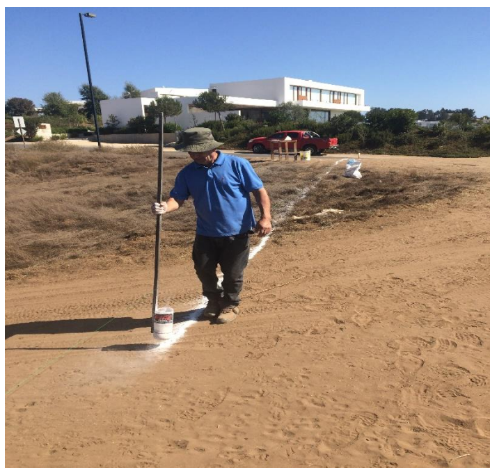
Figura 4-1. Demarcación de terreno
