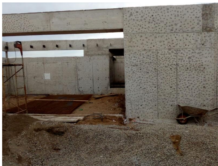
Figura 4-34. Puntereo de muros.
