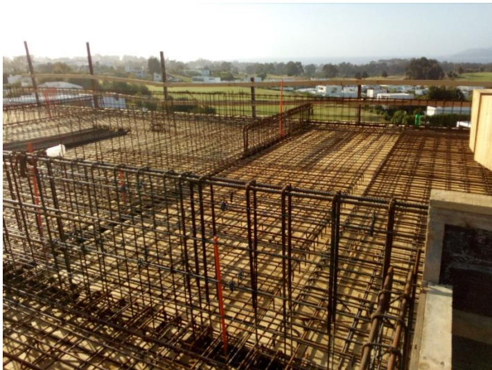
Figura 4-28. Enfierradura de vigas.
