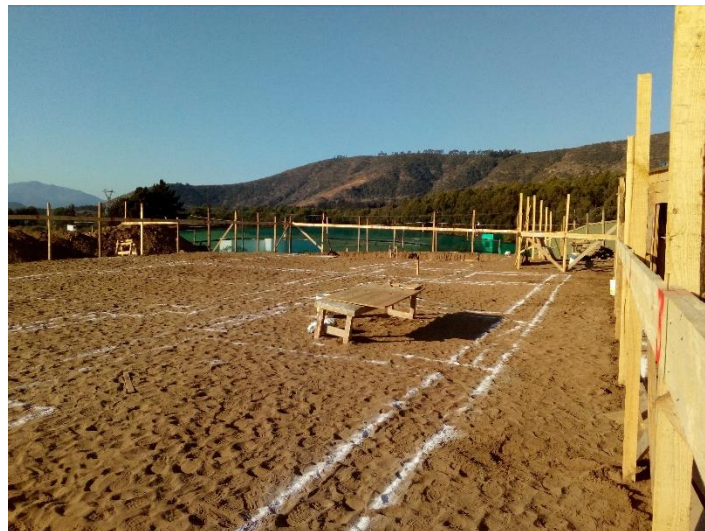
Figura 4-8. Trazado para excavaciones-
