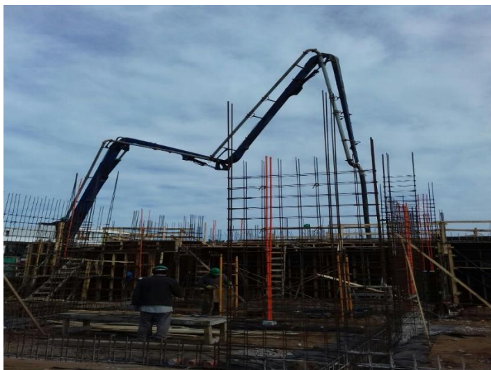
Figura 4-18. Hormigonado de muro.
