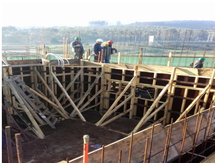
Figura 4-17. Elementos para moldaje.
