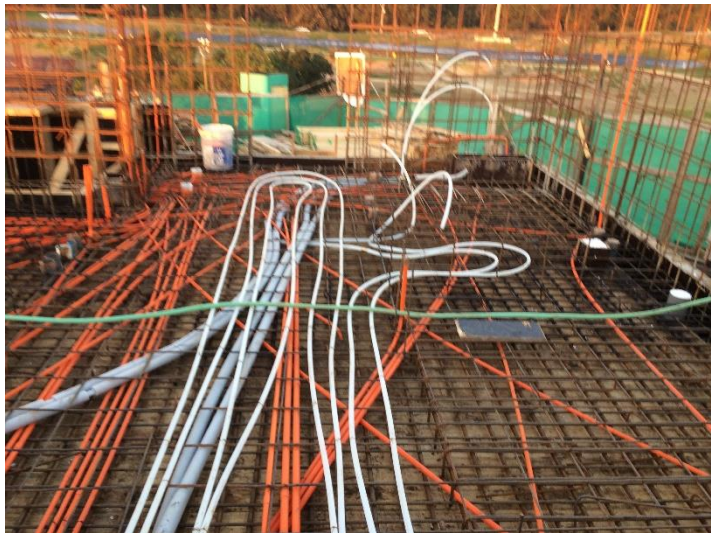
Figura 4-30. Canalización para las instalaciones respectivas.
