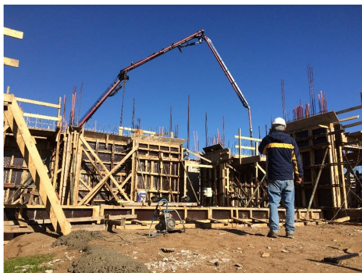
Figura 4-19. Hormigón bombeado.
