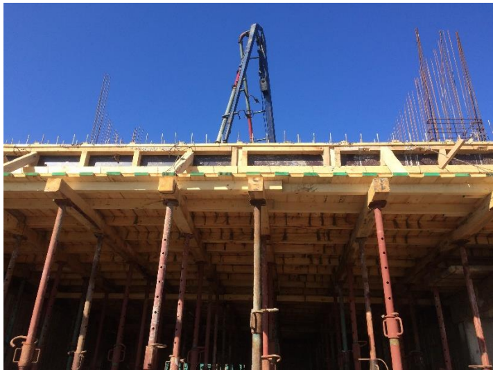
Figura 4-31. Hormigonado de losa.
