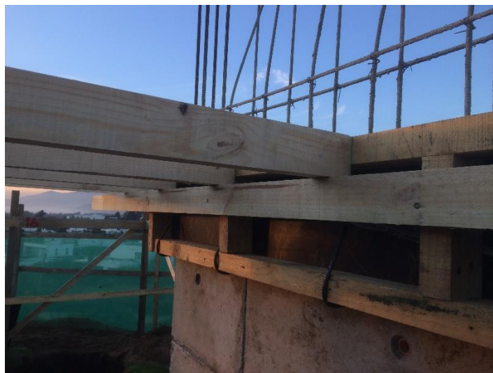
Figura 4-22. Rebalse de losa.
