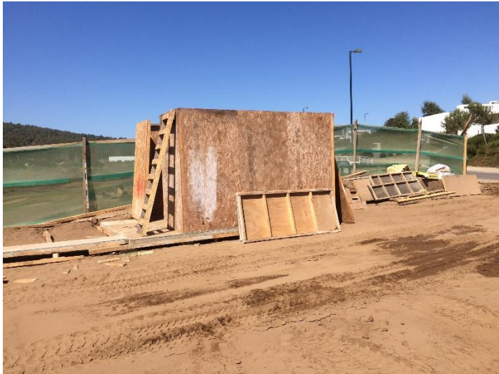
Figura 4-5. Instalación de faenas.
