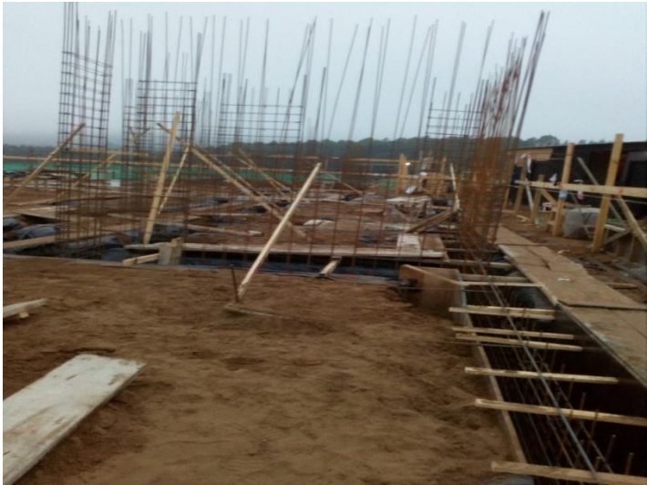
Figura 4-13. Instalación de enfierradura.
