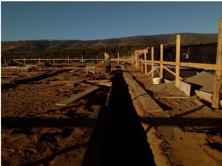
Figura 4-10. Excavación para fundaciones.
