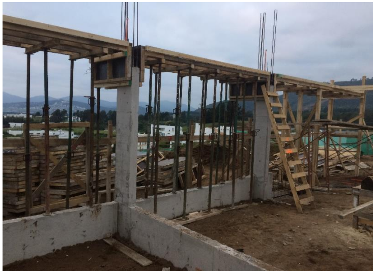
Figura 4-26. Moldaje para vigas.
