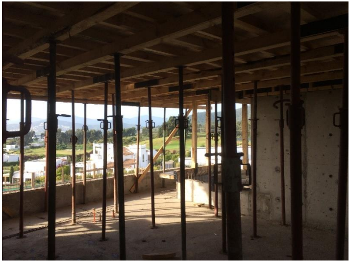
Figura 4-25. Alzaprimado de losa.
