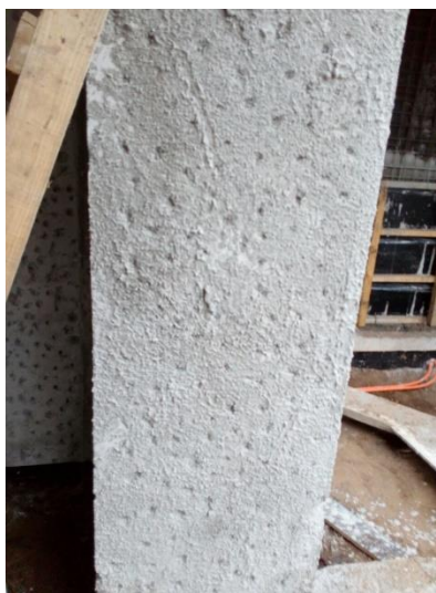
Figura 4-35. Puntero de pilares.
