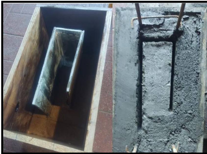
Ilustración 71. Fabricación molde - Cemento
