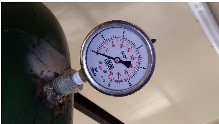
*Figura 20 Manómetro en la Entrada de cada PAT.*
