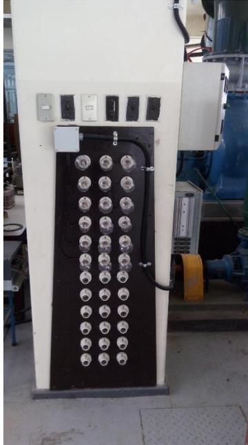
*Figura 22 Tablero de ampolletas, sistema de disipación energía generador monofásico*
