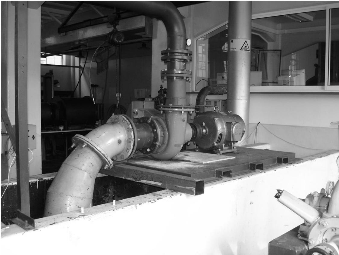
*Figura 2 Esquema Instalación Banco Ensayos PAT. Luis Cáceres*
