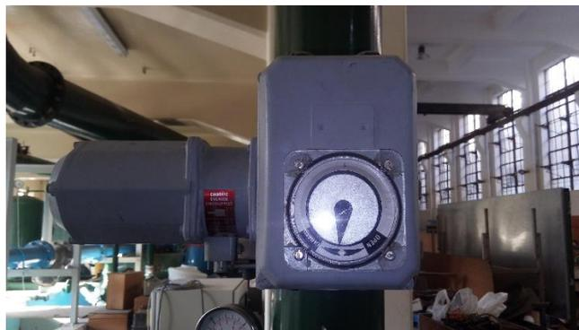
*Figura 18 Válvula reguladora de caudal Sistema de Alimentación.*
