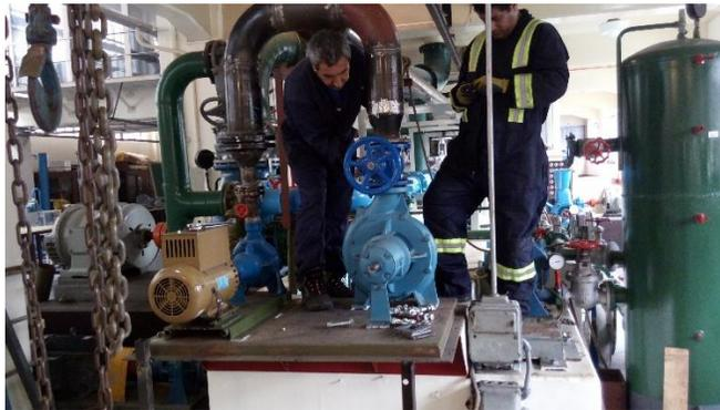
*Figura 38 Conexión válvula PAT.*
