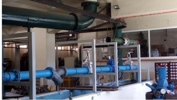
*Figura 32 Instalación tuberías banco ensayo.*
