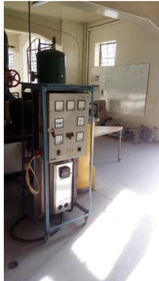
*Figura 47 Tablero eléctrico y controlador de frecuencia generador trifásico.*
