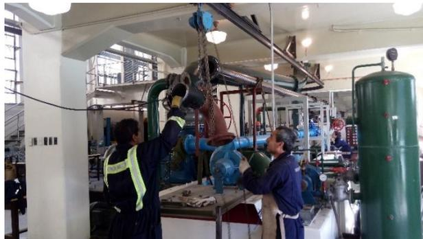
*Figura 34 Conexión sistema codo-tee con flange tubería*
