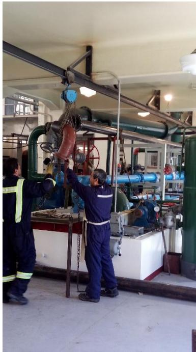
*Figura 36 Instalación codo en sistema de tuberías banco de ensayo.*
