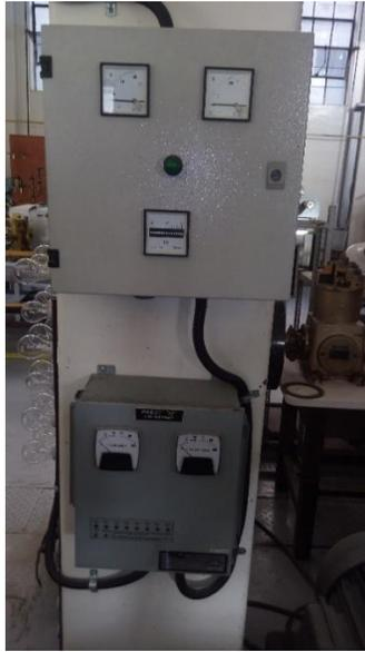
*Figura 46 Tablero eléctrico y controlador de frecuencia generador monofásico*
