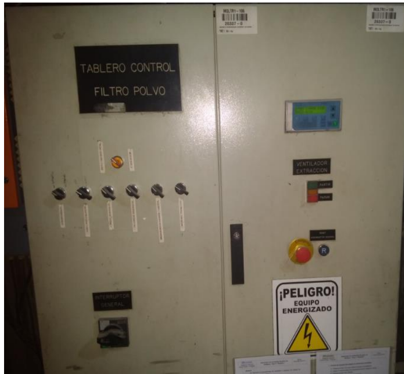
Vista exterior Antiguo Sistema de Control.
