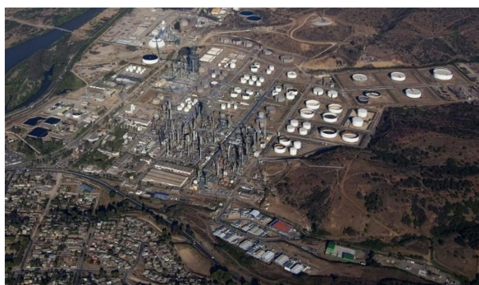
Imagen 1-1: Vista aérea ENAP Refinería Aconcagua
