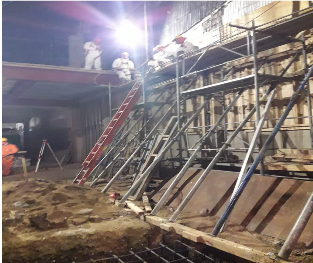
FIGURA 2.22 – MOLDAJES MURO HORMIGÓN ARMADO EDIFICIO CORONA VIÑA DEL MAR
