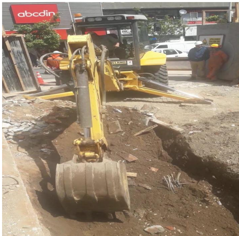
FIGURA 2.19 – EXCAVACIÓN FUNDACIÓN CORRIDA EJE B-A EDIFICIO CORONA VIÑA DEL MA
