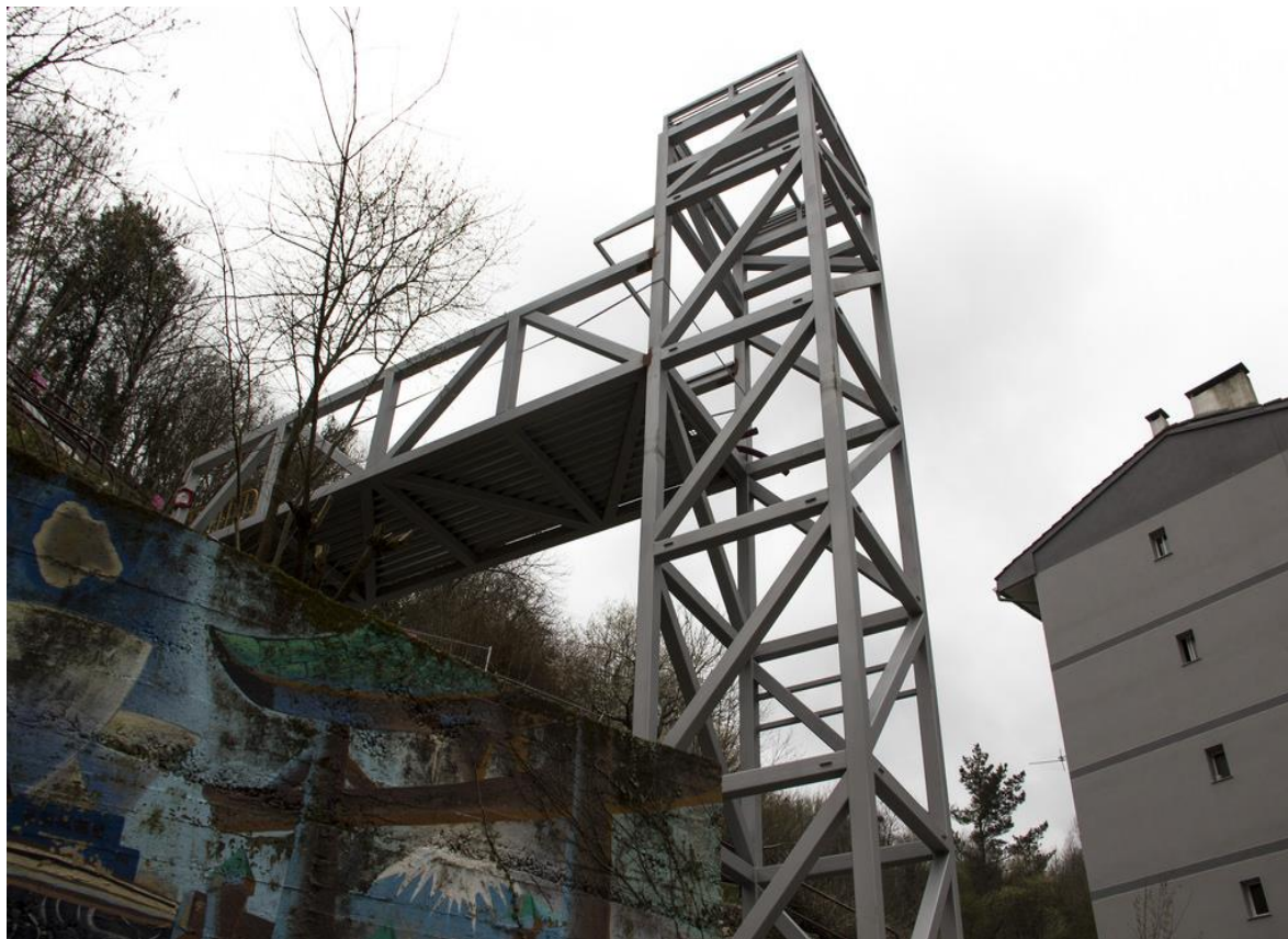
FIGURA 2.13 – EJEMPLO ESTRUCTURA USADA PARA ASCENSOR EDIFICIO CORONA VIÑA DEL MAR
