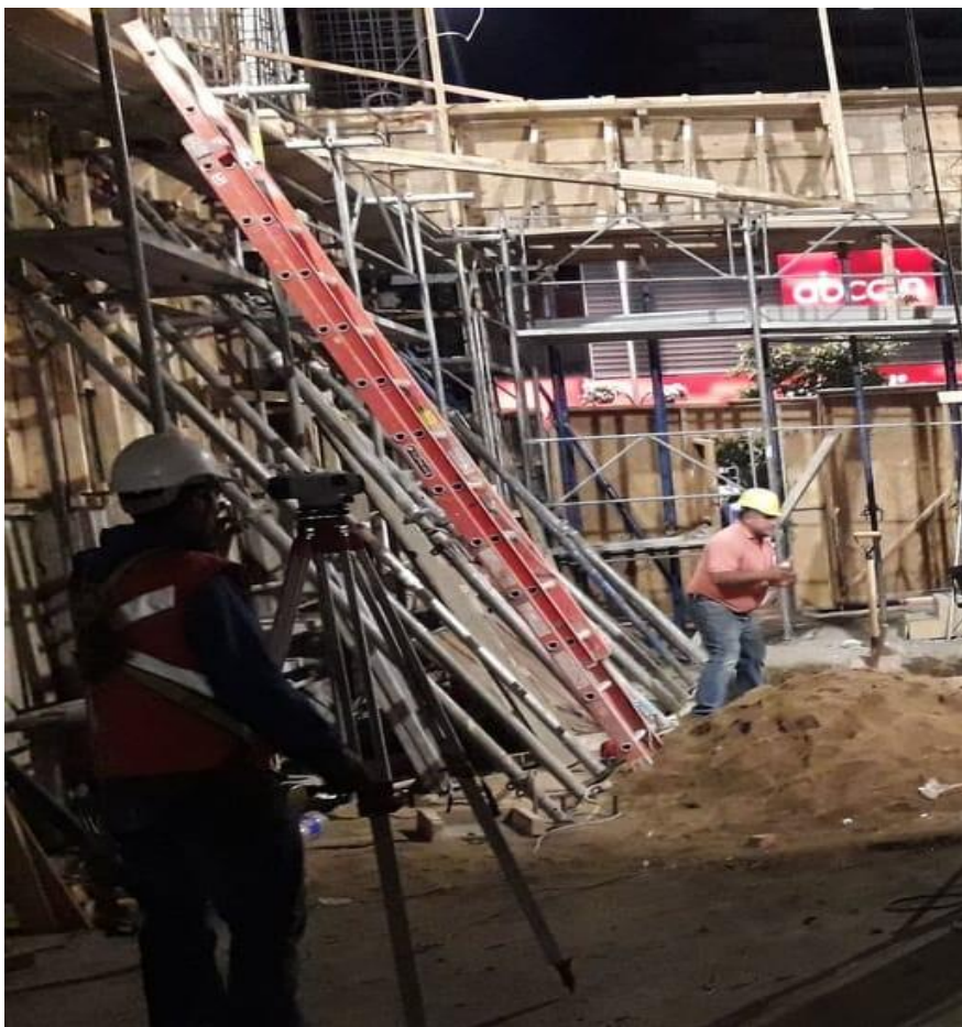
FIGURA 2.18 – NIVEL TOPOGRÁFICO USADO EN LA OBRA EDIFICIO CORONA VIÑA DEL MAR
