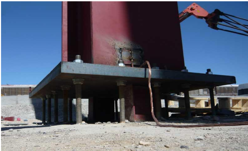
FIGURA 2.8 – EJEMPLO DE PILAR LISTO PARA APLICAR MORTERO SIN
