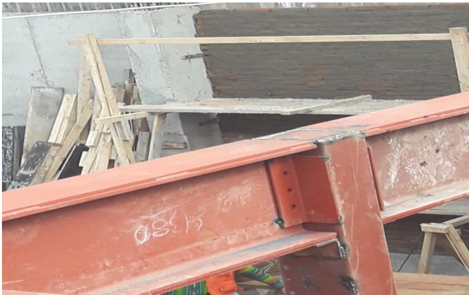
FIGURA 2.9 – UNIÓN VIGA-VIGA ESTRUCTURA METÁLICA EDIFICIO CORONA VIÑA DEL MAR
