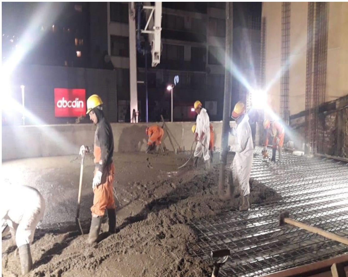
FIGURA 2.24 – HORMIGONADO DE LOSA COLABORANTE EDIFICIO CORONA VIÑA DEL MAR
