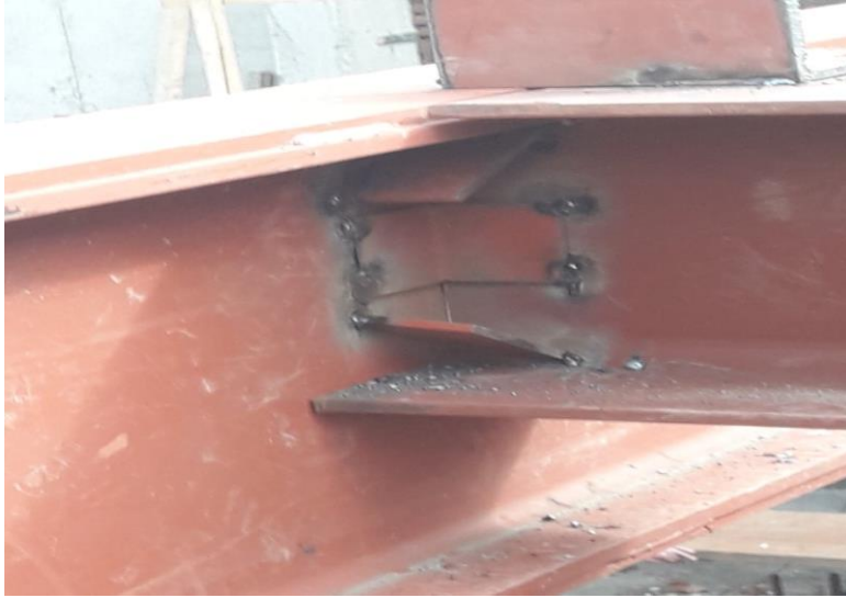
FIGURA 2.9 – UNIÓN VIGA-VIGA ESTRUCTURA METÁLICA EDIFICIO CORONA VIÑA DEL MAR
