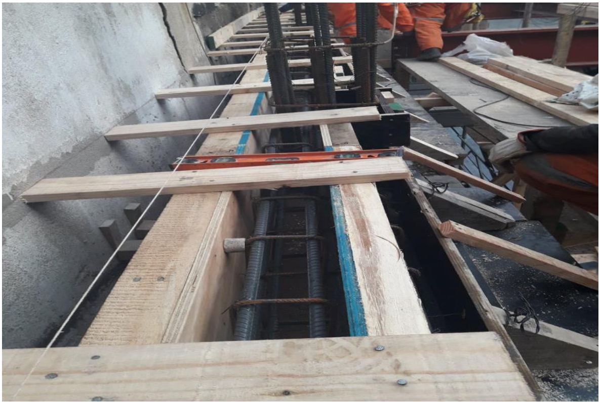
FIGURA 2.15 – VIGA CORONACIÓN PRIMER NIVEL EDIFICIO CORONA VIÑA DEL MAR
