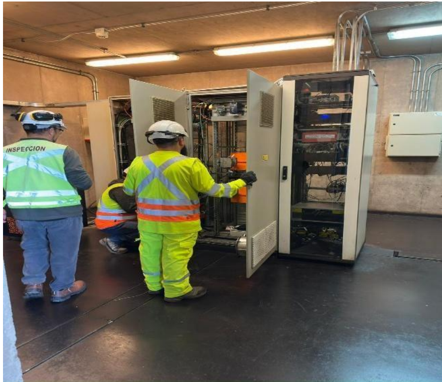
Mantenimiento de preventivo en casetas técnicas
